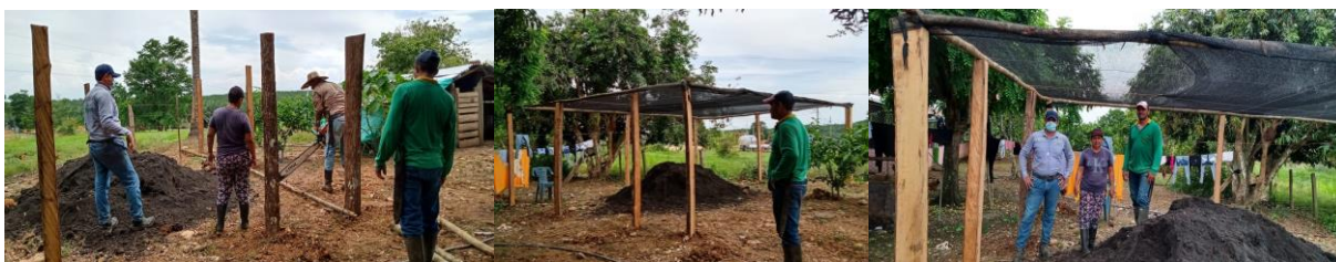
Imagen 2. Adecuación de las huertas caseras
