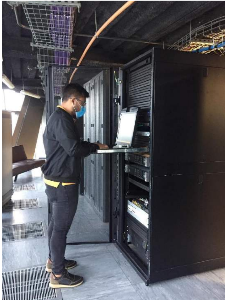
Ilustración 20 Servidor principal del sistema AWOS
