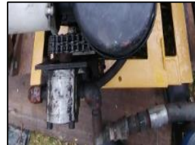
Conductos y mangueras de bomba y cadena (retirar).
