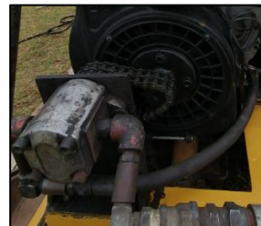
Base soporte de la bomba y línea secundaria de alimentación hidráulica.
