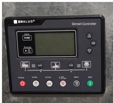
*Fig. 3.15 Modulo de control shaluo SL 6120(Autor).*
