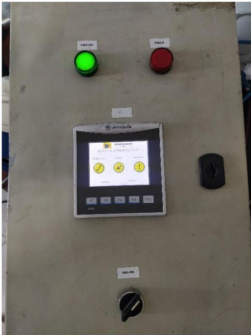
*Fig. 3.85 Pantalla principal del software en el PLC(Autor).*
