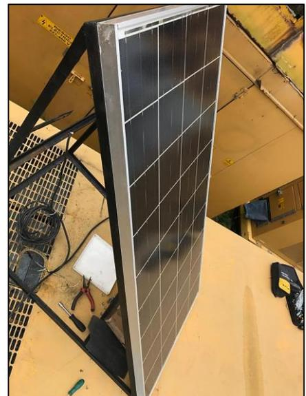
**Fig. 3.40** Instalación de soporte del panel solar (Autor).
