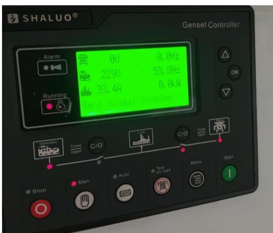
**Fig. 3.37** Pantalla principal de módulo shaluo con carga de 33.4 A (Autor).
