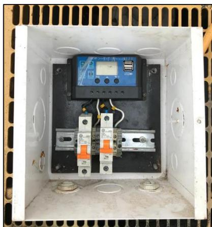
*Fig. 3.43* Armario de control para el panel solar (Autor).
