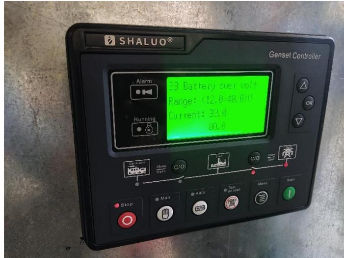
*Fig. 3.31 Parámetro Battery over volt en módulo shaluo(Autor).*
