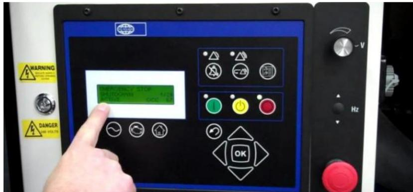
*Fig. 2.10 Panel de control en generador. [6]*
