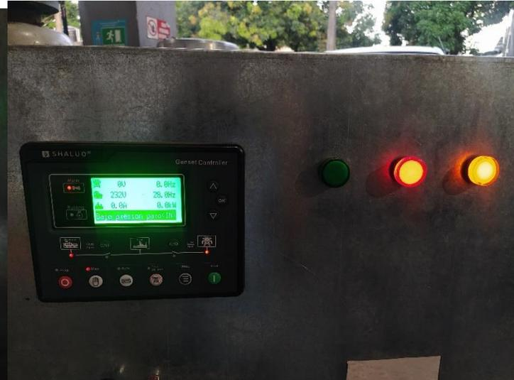
**Fig. 3.35** Pantalla módulo shaluo con falla por alta temperatura(Autor)
