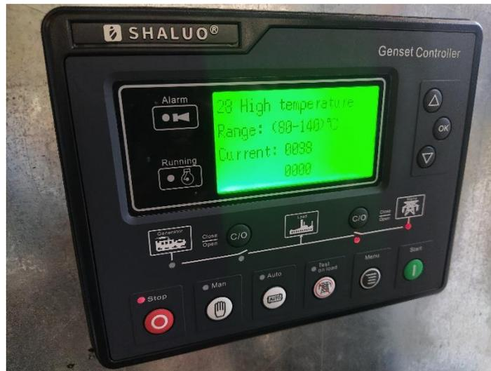
*Fig. 3.29 Parámetro High temperature en módulo shaluo(Autor).*
