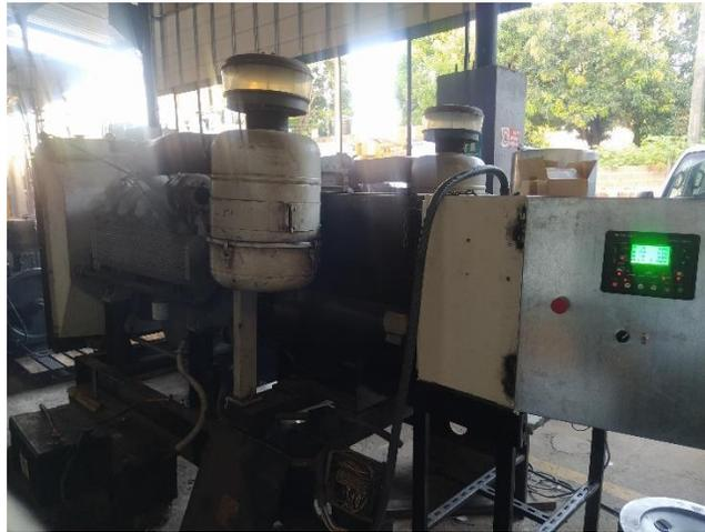
*Fig. 3.14* Generador de alta potencia con el módulo de control shaluo(Autor).
