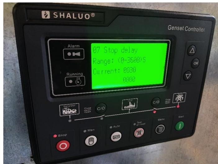
*Fig. 3.19 Parámetro Stop delay en módulo shaluo(Autor).*
