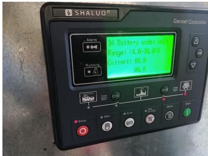
*Fig. 3.32 Parámetro Battery under volt en módulo shaluo(Autor).*
