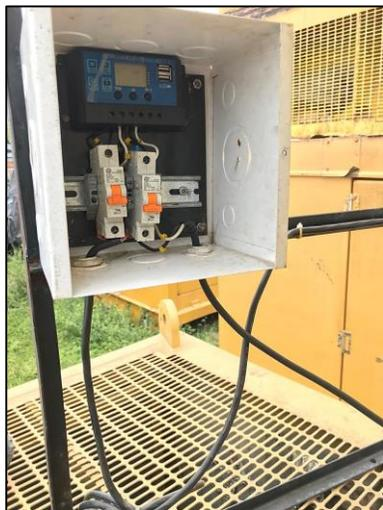
**Fig. 3.45** Conexiones para del panel hacia la batería(Autor).
