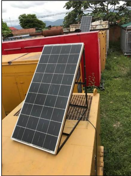
*Fig. 3.47 Panel solar alimentando la batería de un generador (Autor).*
