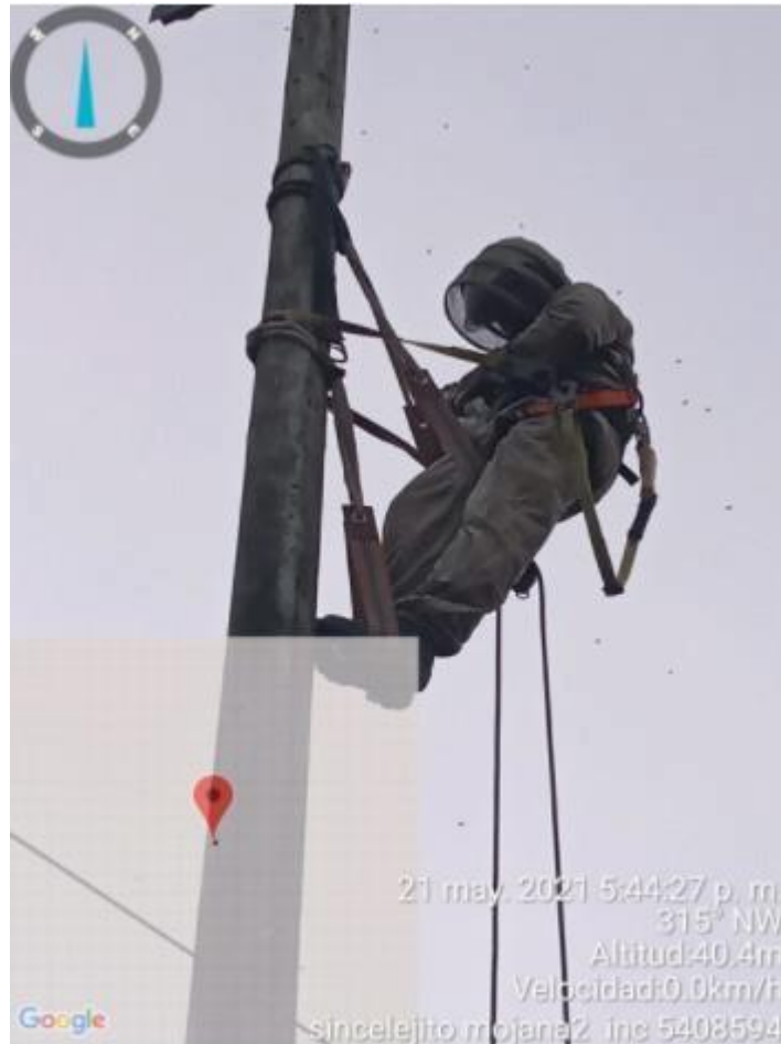
Ilustración 53 ZONA PELIGROSA ABEJAS
