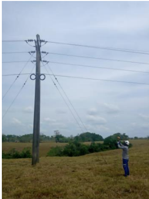
Ilustración 4 Utilización del operario
