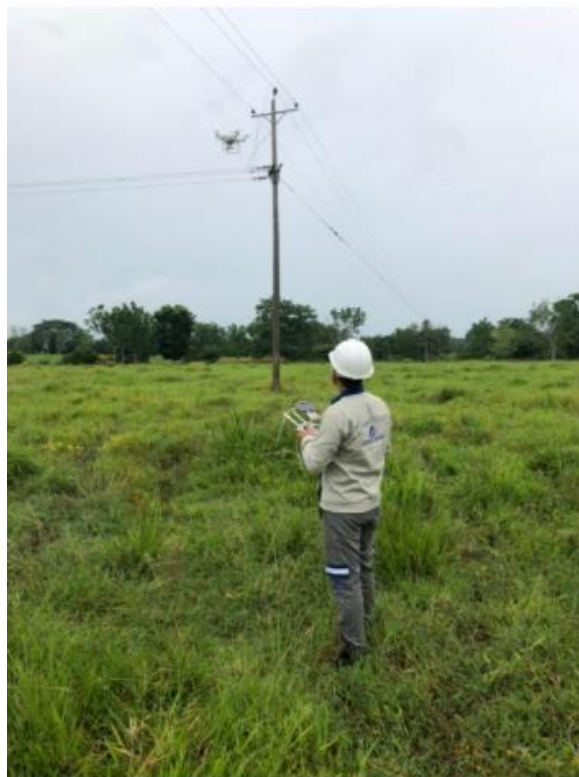
Ilustración 10 Inspección moderno utilización dron
