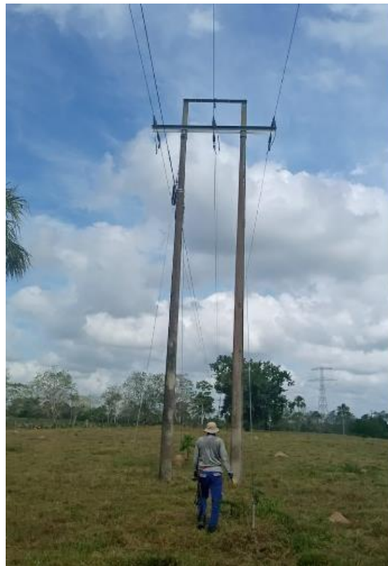
Ilustración 1 Inspección visual sobre las estructuras
