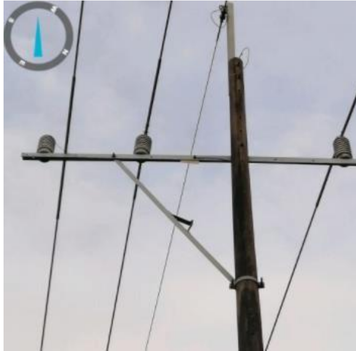
Ilustración 26 . Línea lateral izquierda sin preformado
