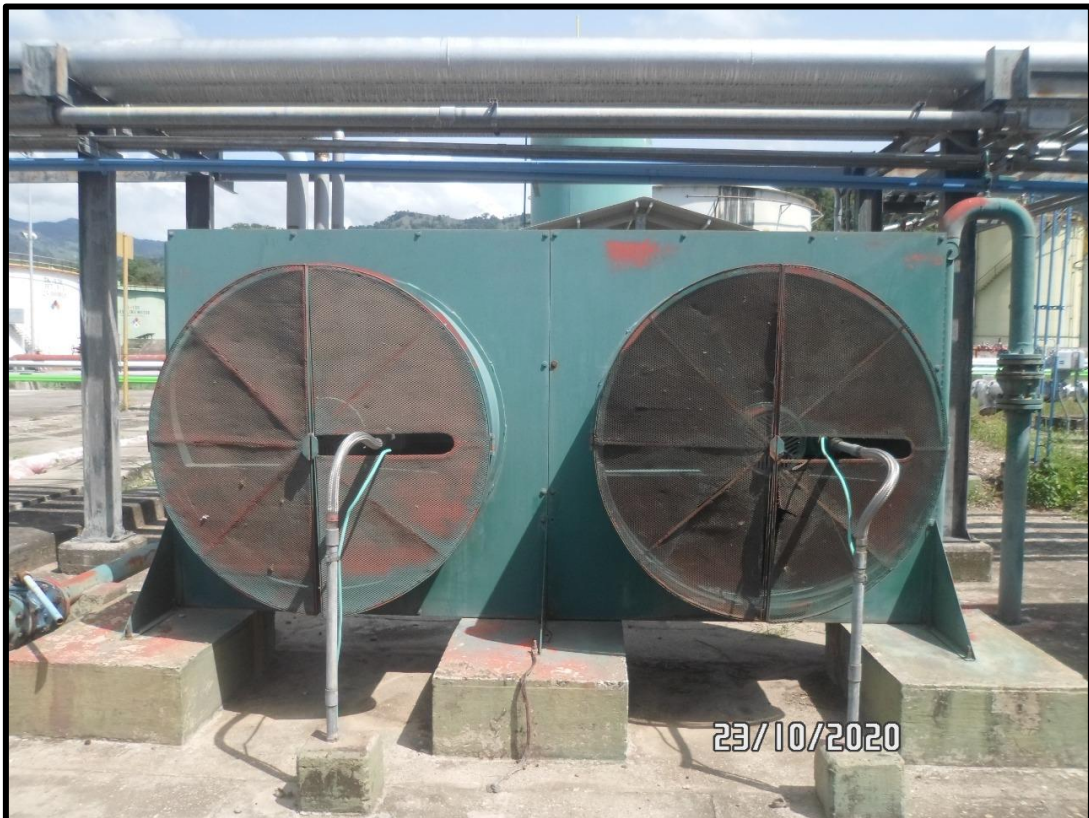
Figura 94. Sistema de refrigeración por radiador de unidades principales 2420 y 2430. Fuente: Base de datos de Stor
