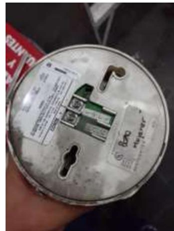
Figura 13. Detector de humo polvoriento. [ING FIRE]
