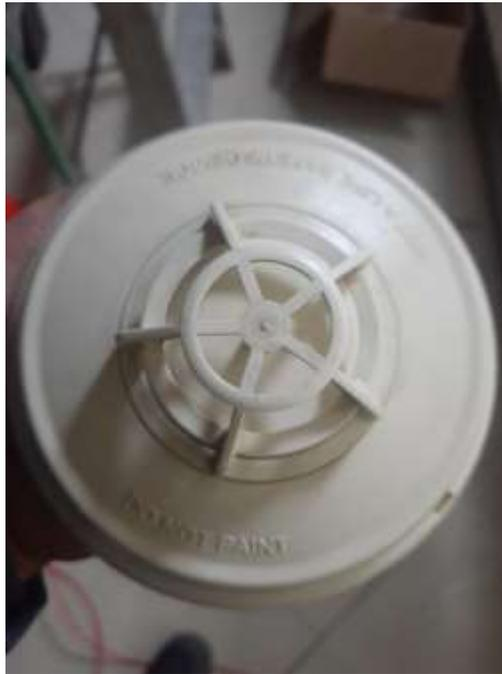
Figura 52. Sensor térmico con mantenimiento realizado. [ING FIRE]
