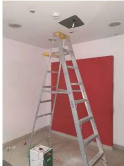
Figura 49 y 50. Apertura de techos por no acceso al cableado de la red. [ING FIRE]
