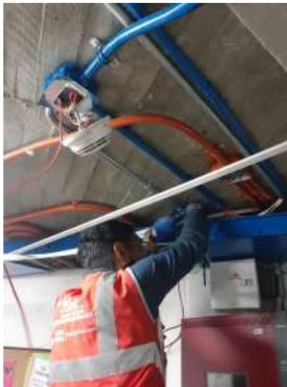
*Figura 55. Nuevo lazo de control instalado. [ING FIRE]*
