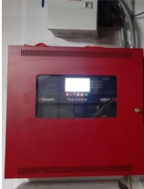
Figura 60. Panel de control Simplex 4007 instalado. [ING FIRE]
