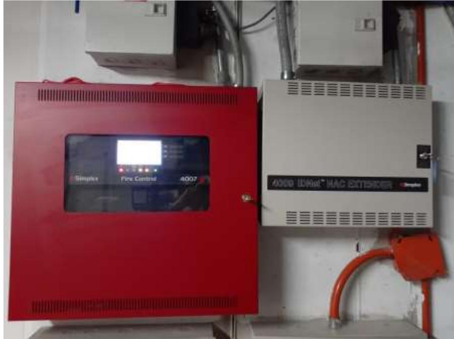
*Figura 69. Instalación completa de panel y fuente auxiliar Plaza 54. [Autor]*
