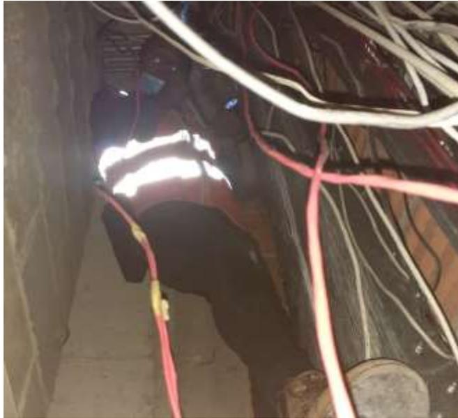
*Figura 36. Seguimiento de cables no conectados. [ING FIRE]*
