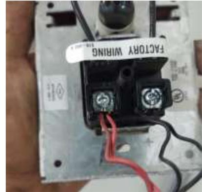
Figura 7. E.M Con polaridad invertida. [ING FIRE]
