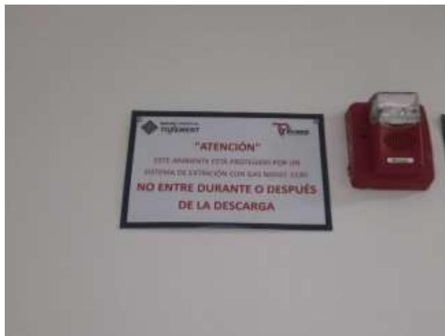
Figura 116. Aviso de peligro por gas inerte (agente limpio) . [ING FIRE]
