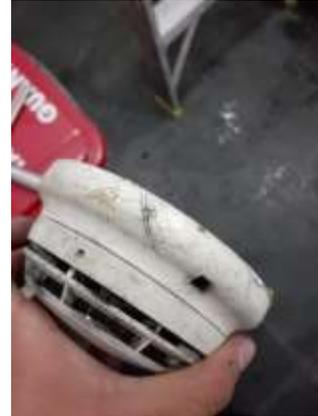
Figura 11. Detector de humo sin mantenimiento. [ING FIRE]
