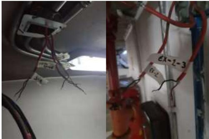
*Figura 2. Identificación de cableado red contra incendios. [ING FIRE]*
