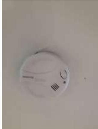
Figura 14. Detector de humo de baterías. [ING FIRE]
