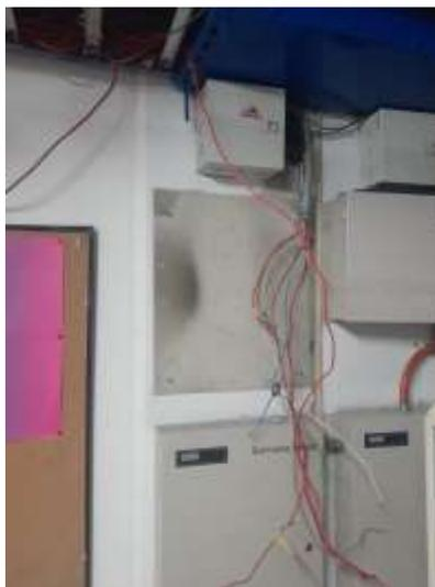
*Figura 56. Desinstalación de panel Simplex 4010. [ING FIRE]*
