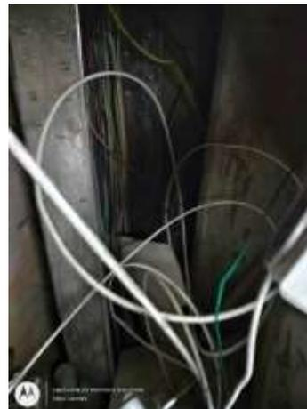
*Figura 25. Cableado cortado y en corto. [ING FIRE]*
