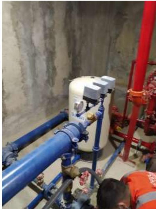
Figura 123. Tanque auxiliar instalado. [ING FIRE]
