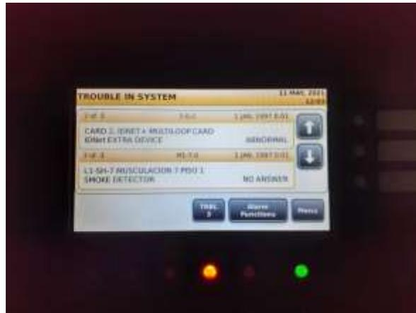
Figura 67. Panel de control Simplex de BODYTECH con problemas. [Autor]
