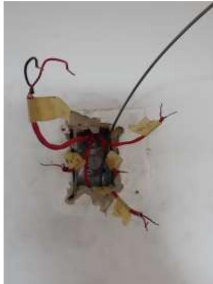
Figura 41. Reordenamiento de cables y eliminación de añadiduras. [ING FIRE]
