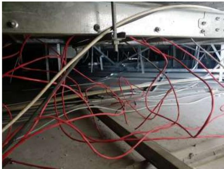
*Figura 39. Eliminación de cable extra sobre el techo. [ING FIRE]*
