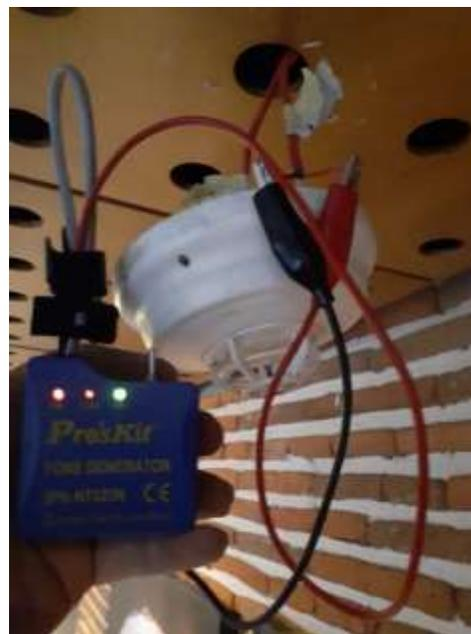
Figura 54. Prueba de funcionamiento lazo de control en dispositivo hallado. [ING FIRE]
