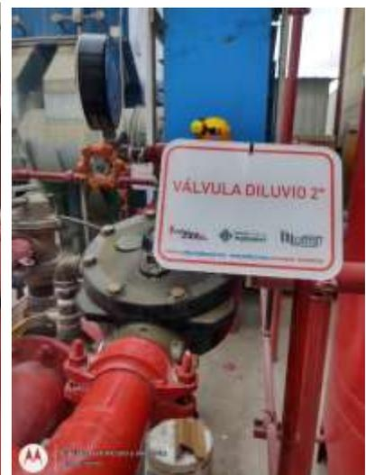
Figura 95. Etiqueta válvula mariposa instalada. [ING FIRE] Figura 96. Etiqueta alarma válvula. [ING FIRE] Figura 97. Etiqueta válvula diluvio. [ING FIRE]
