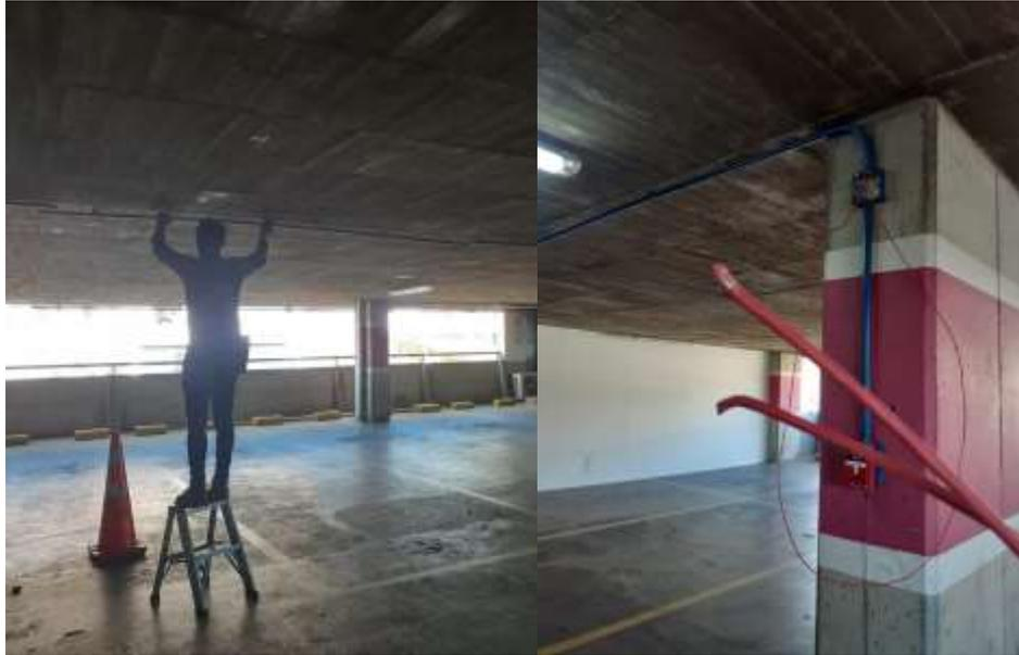
Figura 40. Recableado tercer piso por ruptura de cable en la IPS. [ING FIRE]
