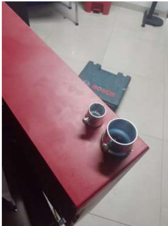
Figura 59. Apertura de orificios para lazos de potencia y control. [ING FIRE]
