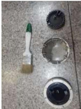
Figura 34. Limpieza a detector encontrado. [ING FIRE]
