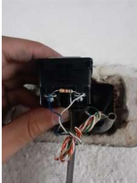
Figura 46. Módulo de supervisión de salida de emergencia reemplazado. [ING FIRE]
