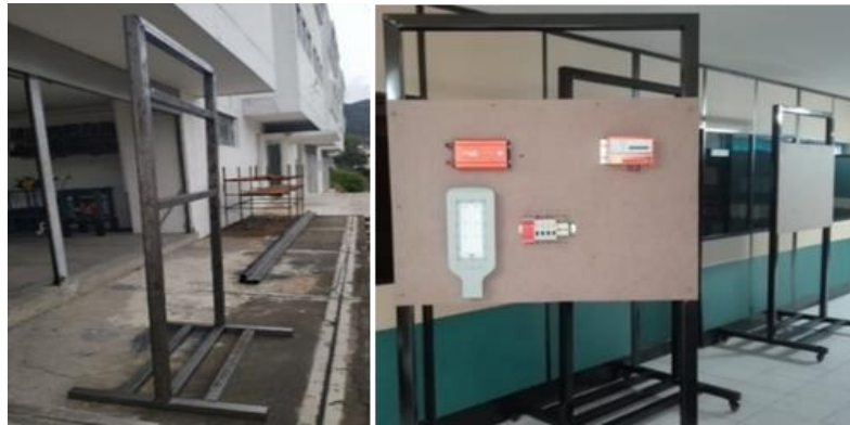
Figura 25. Fase 1 de construcción
