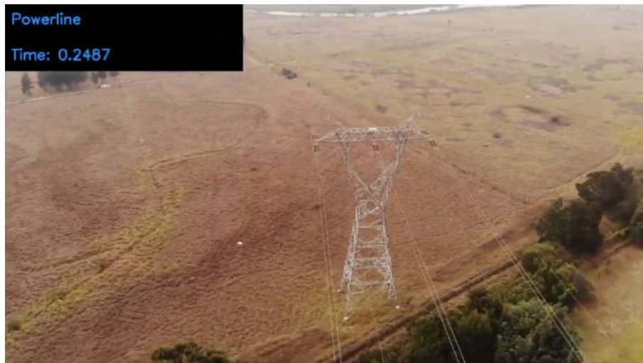
Figura 6.10: Sistema de detección de infraestructura eléctrica usando el sistema operativo Linux Fuente: Autor
