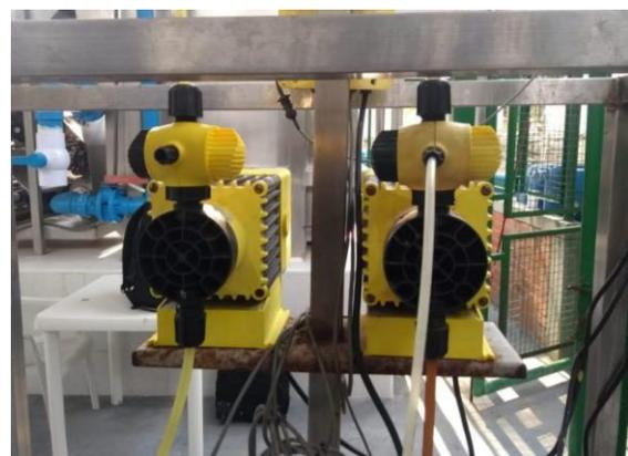
*Fig. 3.42 Prueba de funcionamiento de Sistema de Dosificación. (Autor)*
