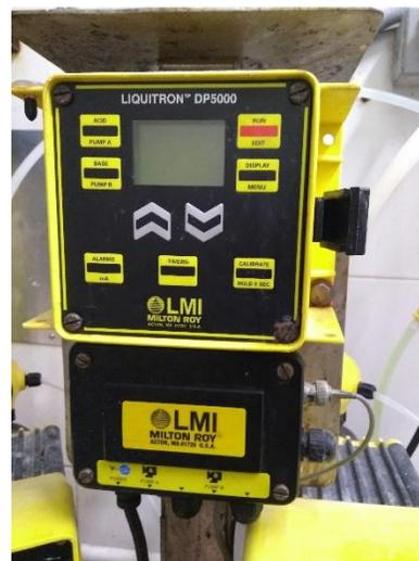
*Fig. 3.44 Controlador para nivel de pH y Sistema de Dosificación. (Autor)*
