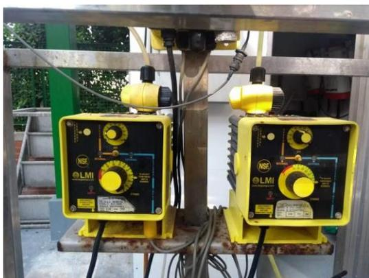
*Fig. 3.41 Instalación de Bombas De dosificación. (Autor)*
