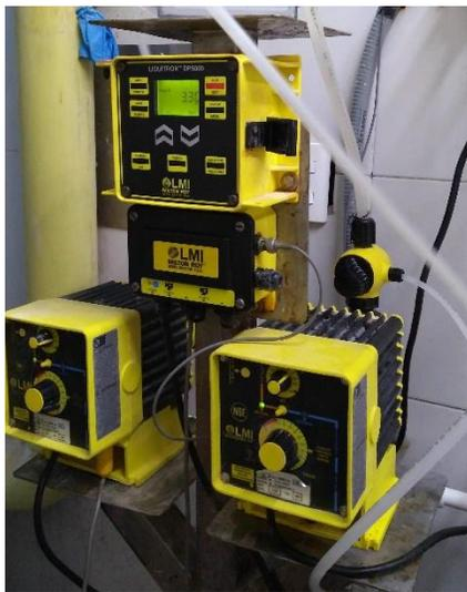
*Fig. 3.43 Sistema de control de Bombas De dosificación. (Autor)*
