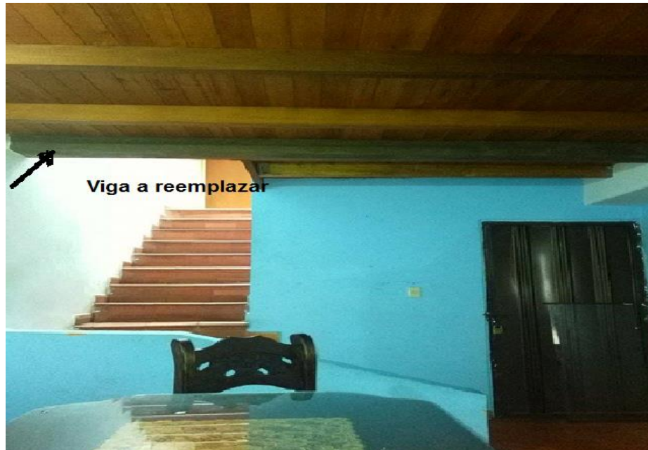
Figura 35. Cubiertas en viviendas resaltado las vigas horizontales
