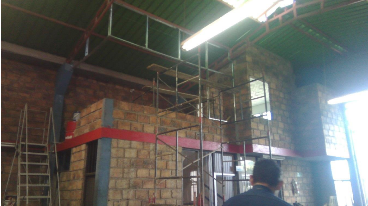
Figura 32: Antes, Segunda Planta Área Administrativa Fuente: (Autor, 2015)
