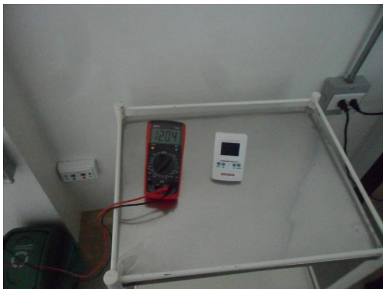
Imagen 29. Medición de voltaje.
