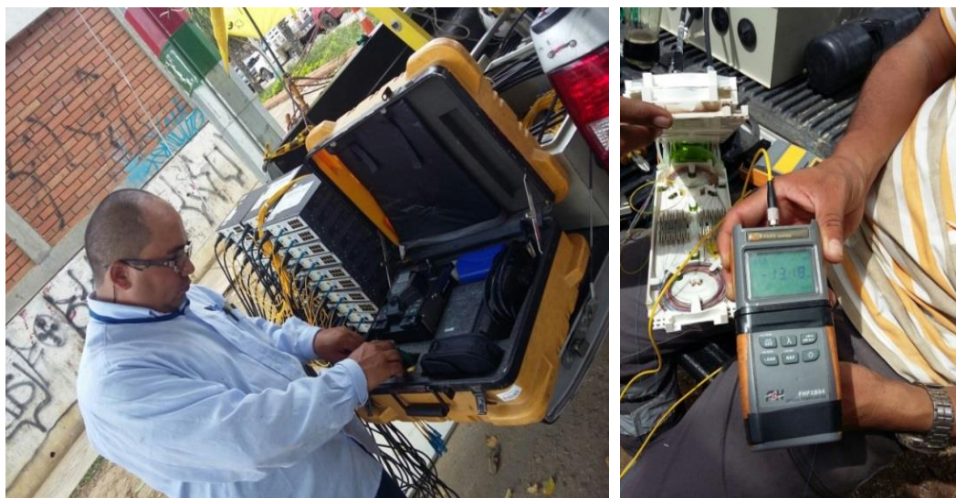
Figura 45. Trabajos de Empalmería y Verificación de Potencia.
