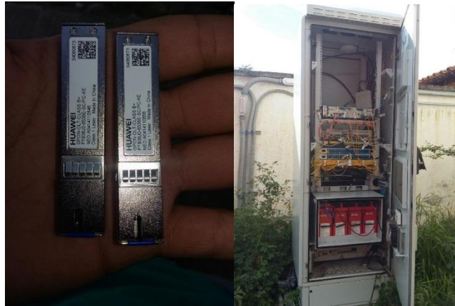
Figura 11. Puertos OLT Clase B+ y Armario de Ubicación OLT, ODF
