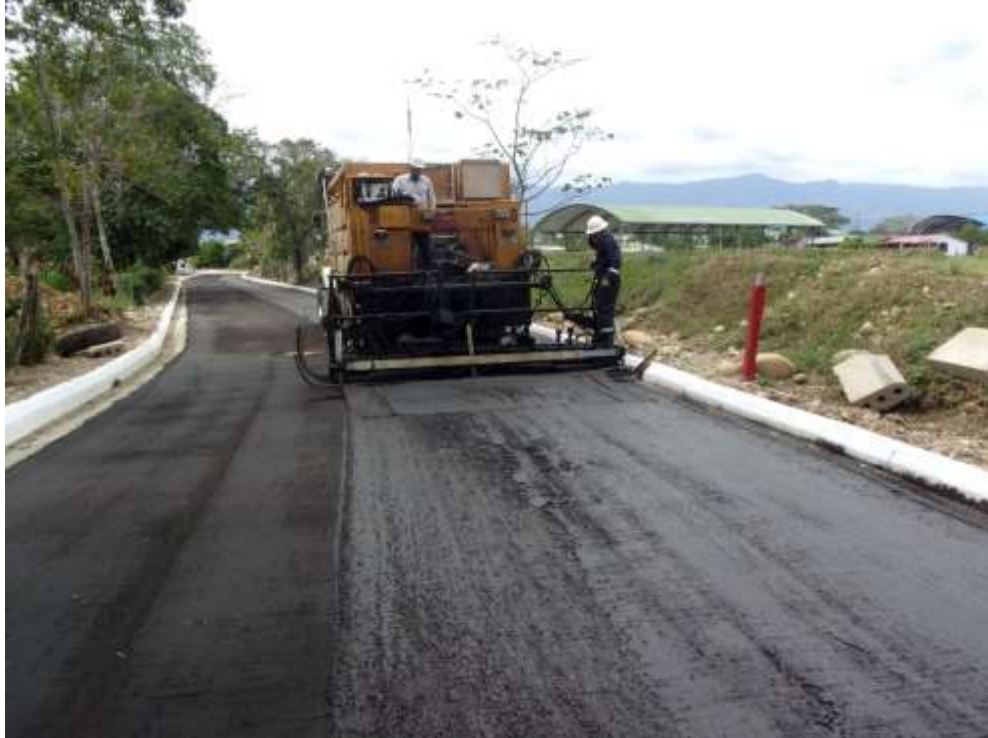
Figura 7. Aplicación micro pavimento.
