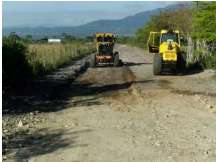
Figura 1. Mantenimiento vial interveredal Monterrey Casanare.
