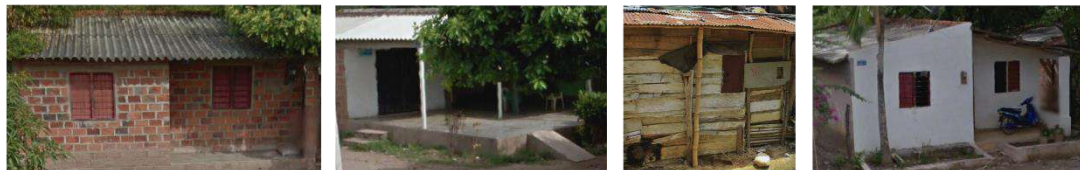
Metal en ventanas
