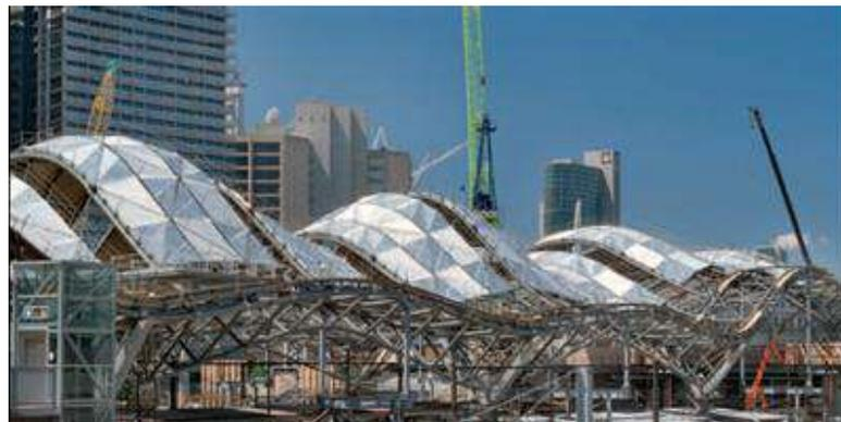
*Ilustración 10. Estructura de la cubierta estación de Southren Cross*
