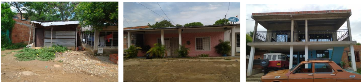
Imagen 5 Alturas de viviendas en asentamiento Villa la Paz.
