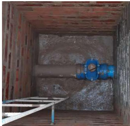
**Figura 88** Válvula de compuerta elástico 6", lavado del tanque contactor
