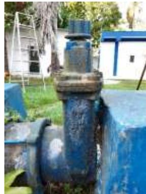
**Figura 83** Válvula de compuerta elástico 8” aguas arriba cámara de aquietamiento.
