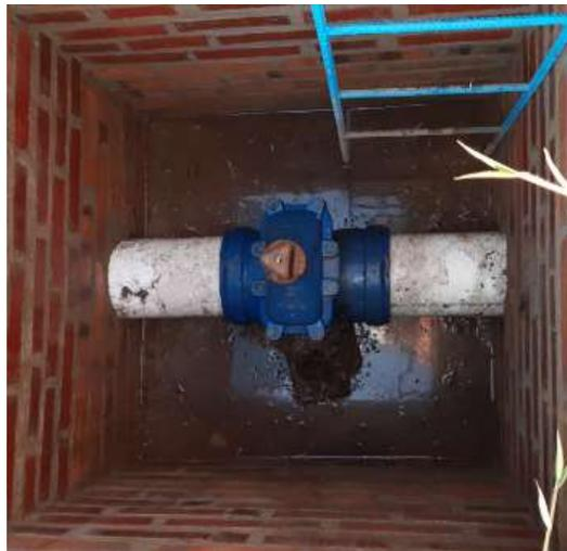
**Figura 90** Válvula de compuerta elástico 8"
