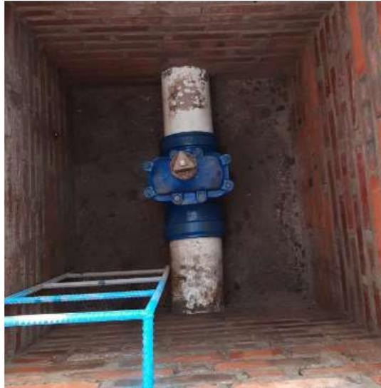
**Figura 89** Válvula de compuerta elástico 8"
