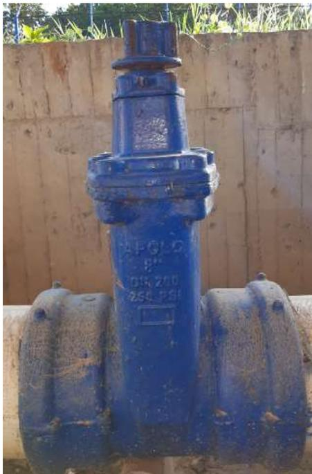
**Figura 91** *Válvula de compuerta elástico 8"*
