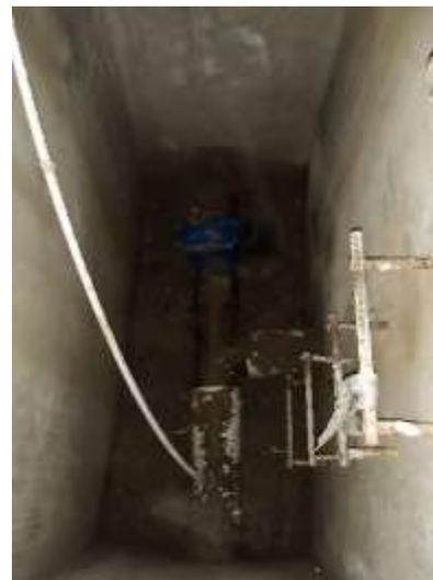
**Figura 86** Válvula de compuerta elástico 8", aguas abajo del canal de aguas claras [Autor]
