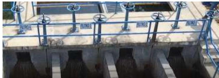
**Figura 84** Válvulas de compuerta, válvulas aguas arriba del filtro y lavado de filtro
