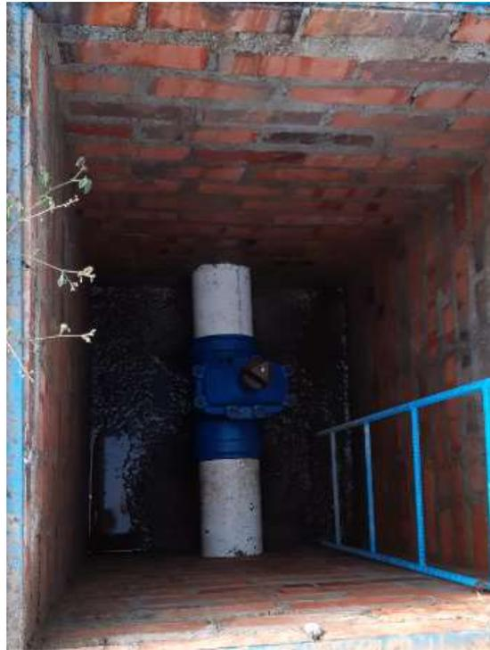
**Figura 87** Válvula de compuerta elástico 8", aguas arriba tanque contactor de cloro
