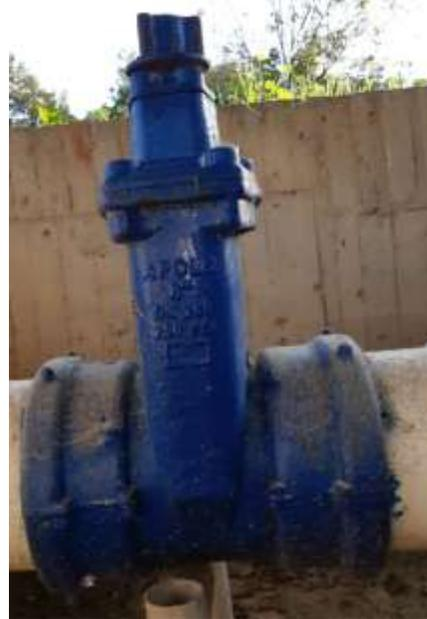
**Figura 92** Válvula de compuerta elástico 8"
