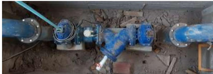
**Figura 81** Sistema de válvulas de 8", medidor de flujo, filtro en Y, aguas debajo de bypass
