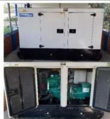
**Figura 107** *Generador eléctrico a combustión*
