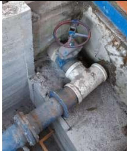
**Figura 80** Bypass Tee 8", entrada de la planta
