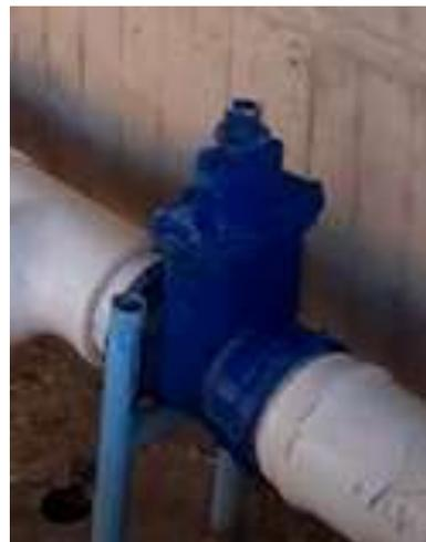
**Figura 93** Válvula de compuerta elástico 8" bypass
