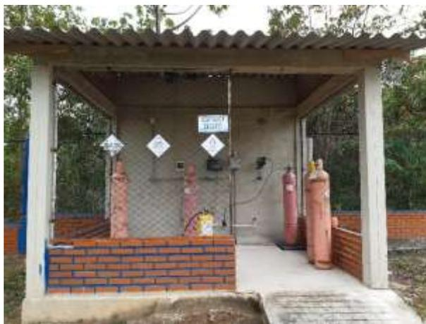
**Figura 98** Caseta de dosificación de hipoclorito de sodio
