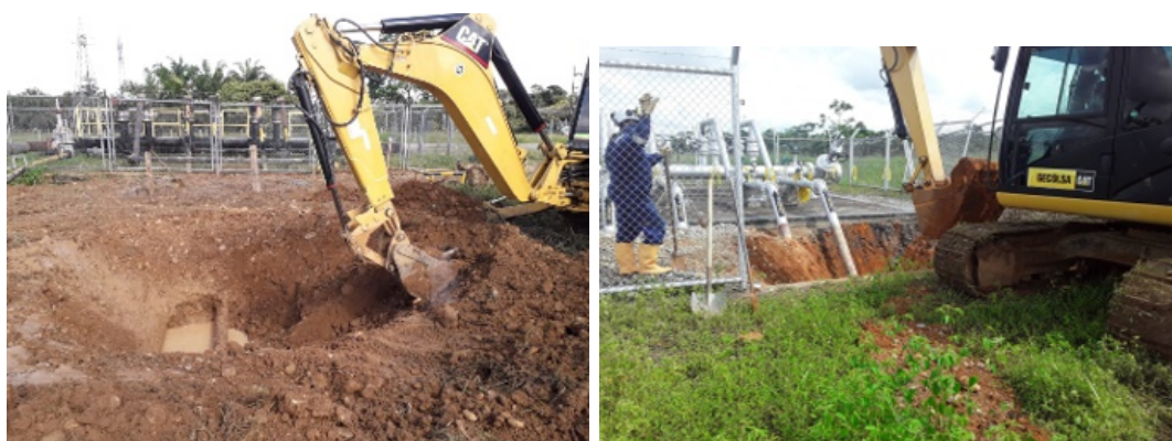
Figura 5.1: Excavación mecánica Fuente: UT VRO / ECP
