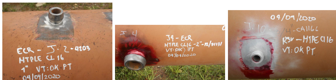
(a) Preparación y Limpieza
