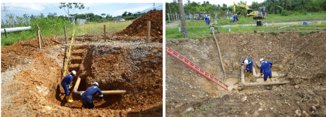
Figura 5.2: Excavación manual Fuente: UT VRO / ECP
