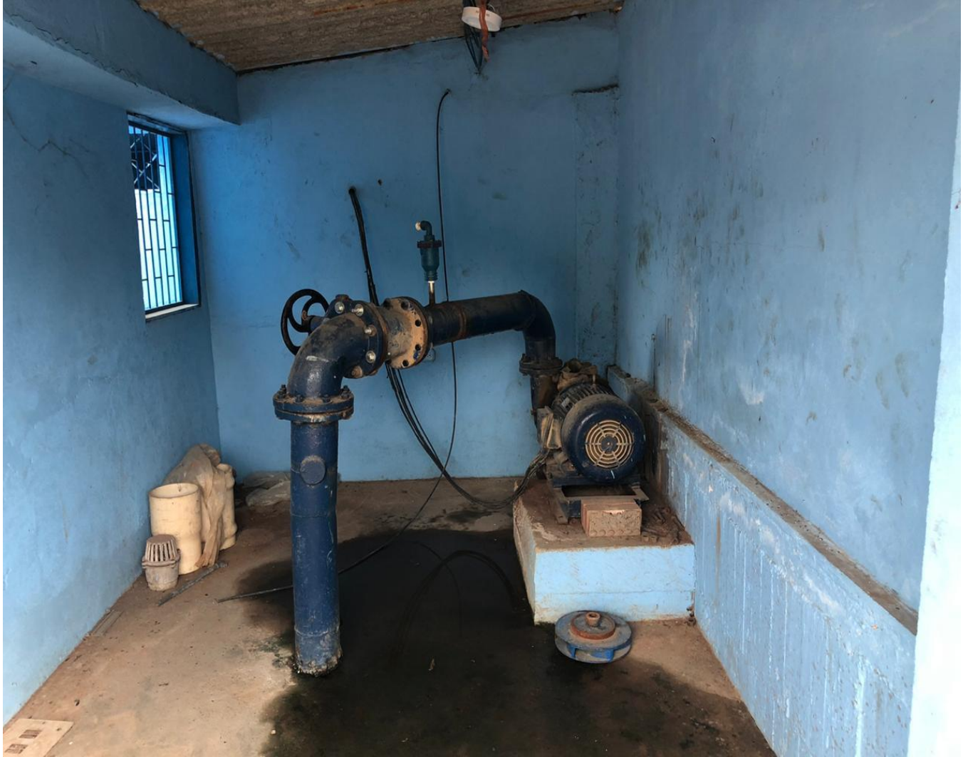
Figura 30 Motor para distribución zona baja.
