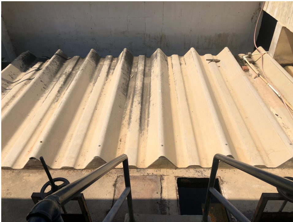
Figura 28 área de tanque de almacenamiento cubierto por techo protector.
