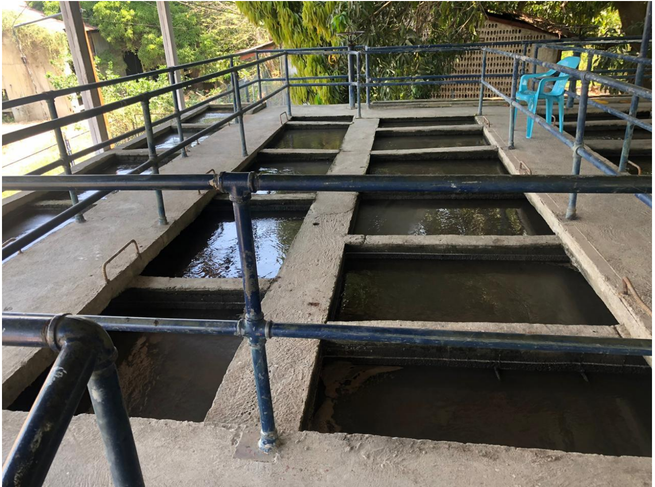
Figura 25 Módulos de floculación.
