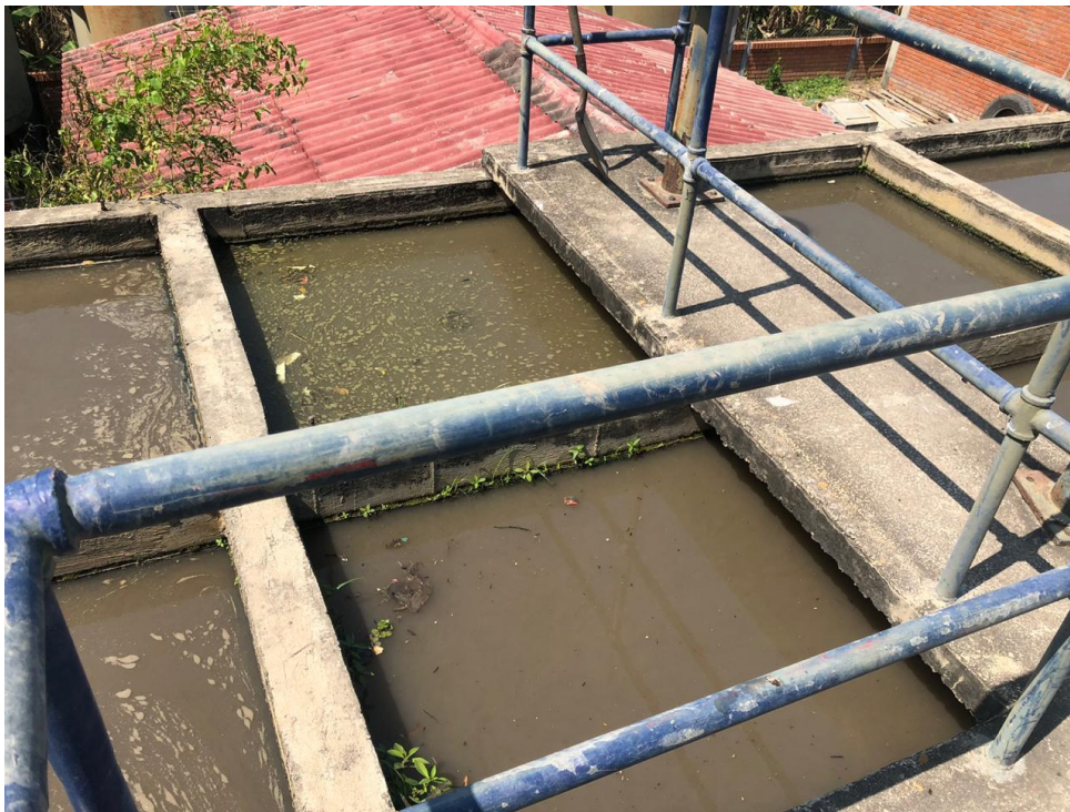
Figura 21 Inicio de desarenadores.
