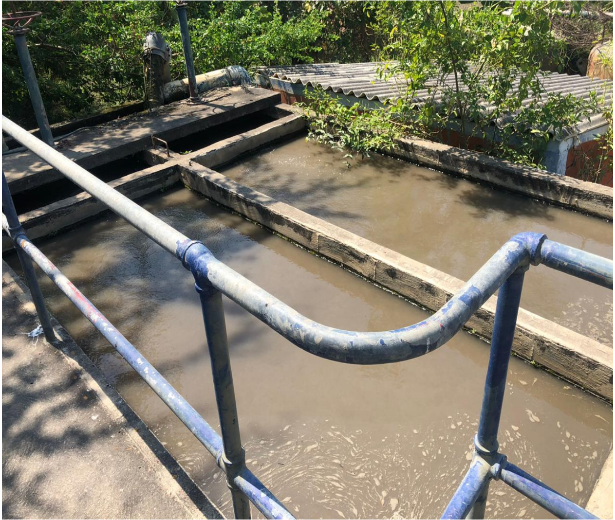
Figura 19 Bocatoma a canal de desarenadores.
