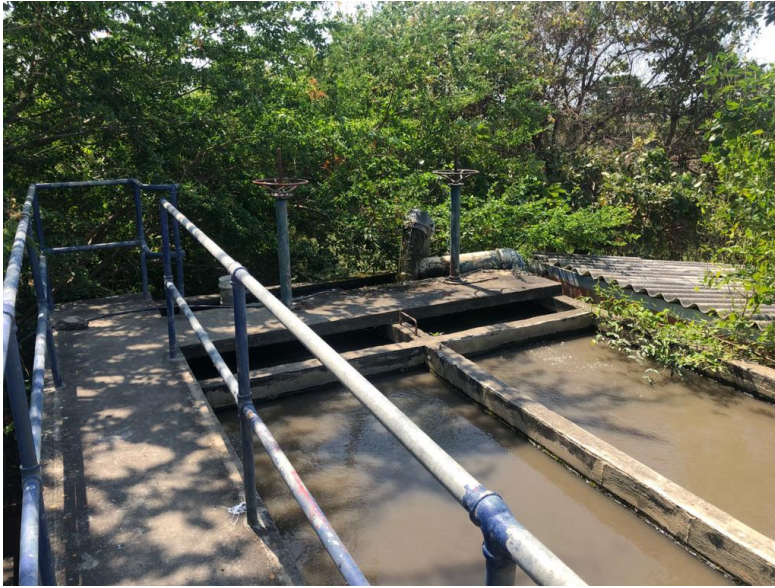
Figura 34 Válvulas inicio de desarenadores.
