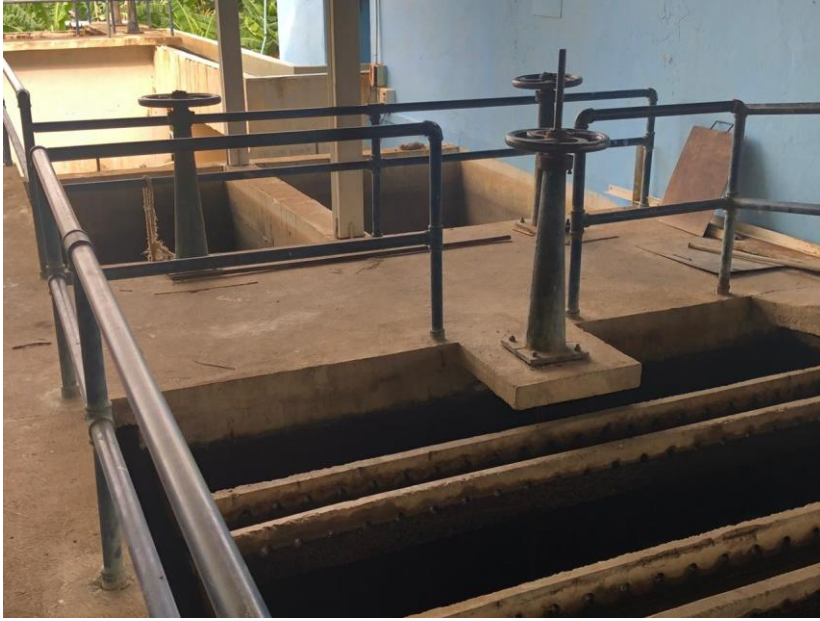
Figura 40 Válvulas de sedimentador derecho.
