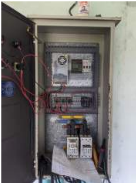
Figura A.3: Cableado del diagrama de mando
