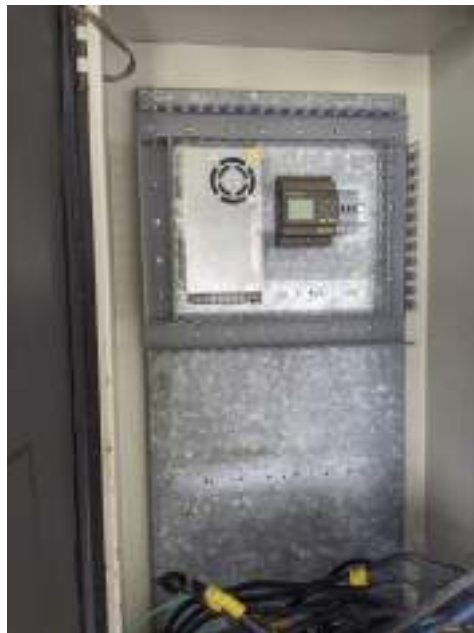
Figura A.5: Fijando la fuente y PLC
