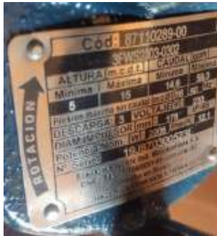
Figura 4.11: Características de la electrobomba.
