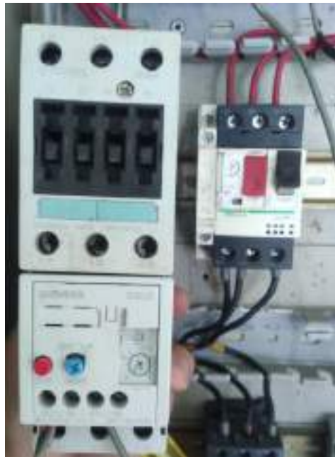
Figura 4.10: Reemplazo relé térmico.
