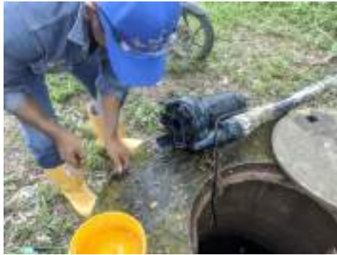
Figura A.2: Montaje electrobomba
