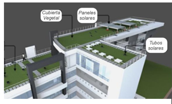
Ilustración 4. Cubiertas y paneles solares
