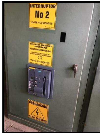
Ilustración 72. Instalación de interruptor automático  $I_n = 1600$  A hasta 500 V. Autor
