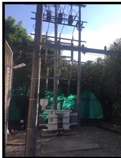
Ilustración 73. Subestación con Transformador de 34.5 Kv. Autor
