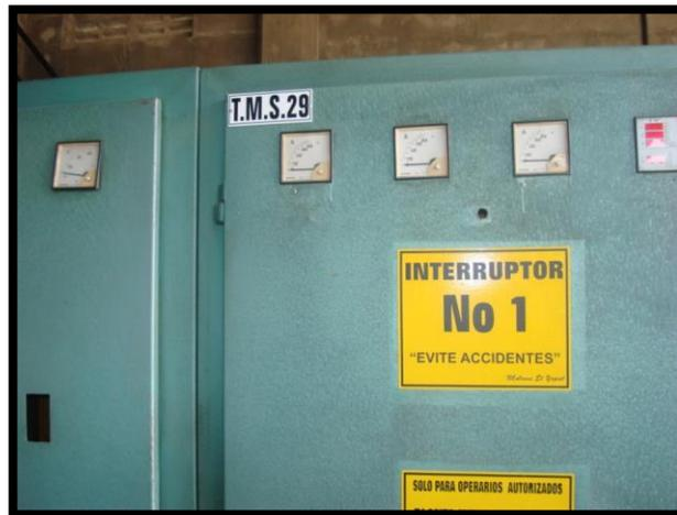
Ilustración 70. Tablero de control de transformador y planta generadora. (Molinos el Yopal Ltda, 2016)
