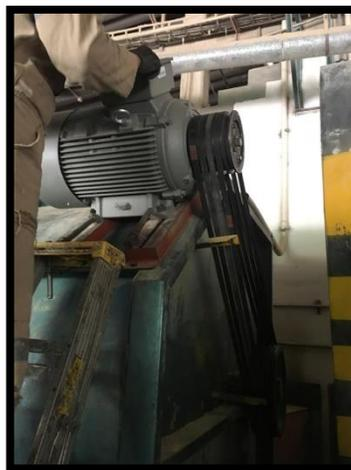
*Ilustración 30. Cambio de Motor de 50 HP 440 V AC. Autor*
