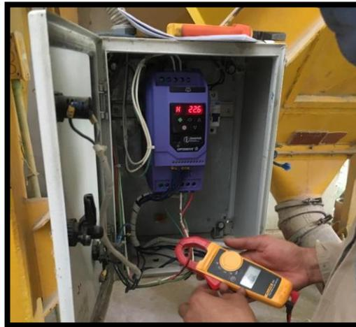
Ilustración 37. Instalación de Variador de Velocidad Secadora de grano Área Secamiento. Autor
