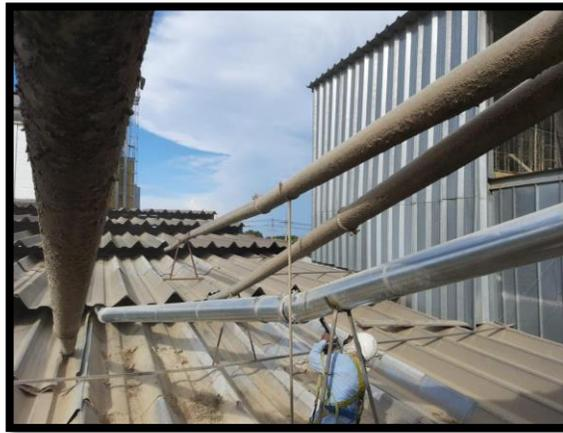
*Ilustración 42. Instalación de tubería de succión de polvo de pre limpia de zaranda paddy seco.
