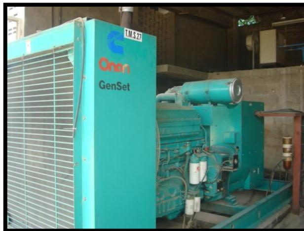
*Ilustración 74. Planta Generadora de 450 DFEC. (Molinos el Yopal Ltda, 2016)*
