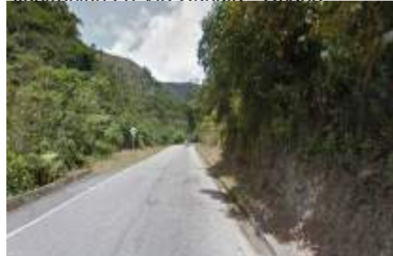
Ilustración 28 Vía Cúcuta - Ocaña
