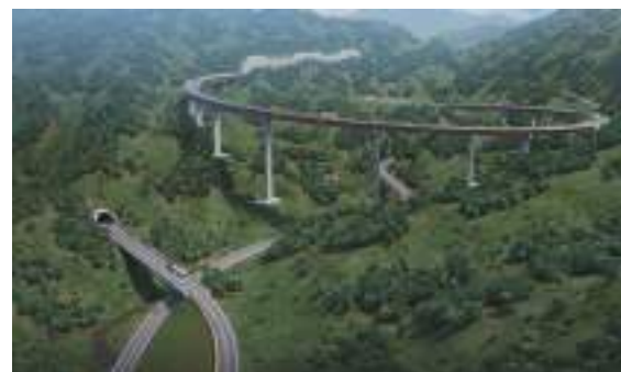
Ilustración 30 Infraestructura vial en desarrollo
