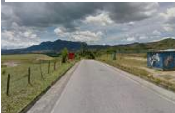
Ilustración 29 Vía Cúcuta - Ocaña
