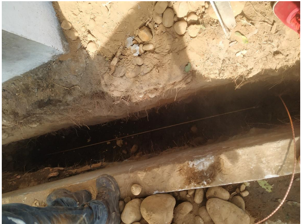
Figura 53. Adaptación suelo, adecuación del espacio para la varilla y cable.
