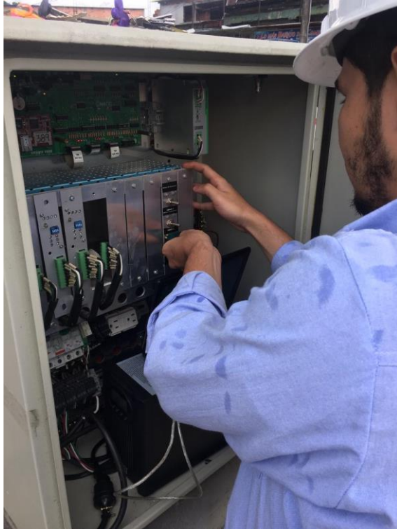
Figura 36. Revisión y mantenimiento, Revisión del estado en la programación de la máquina.
