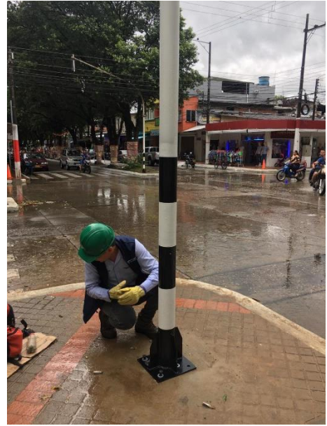
Figura 10. Canastilla Fundida, Apariencia de la canastilla después de fundida, lista para instalación de mástil.
