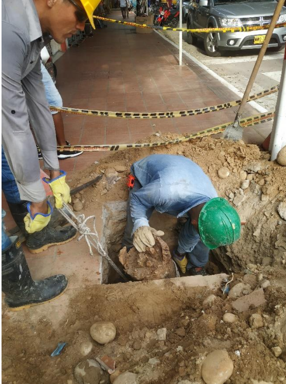
Figura 40. Imprevisto en excavación, Punto de excavación con presencia de un tronco gastando más tiempo del debido.
