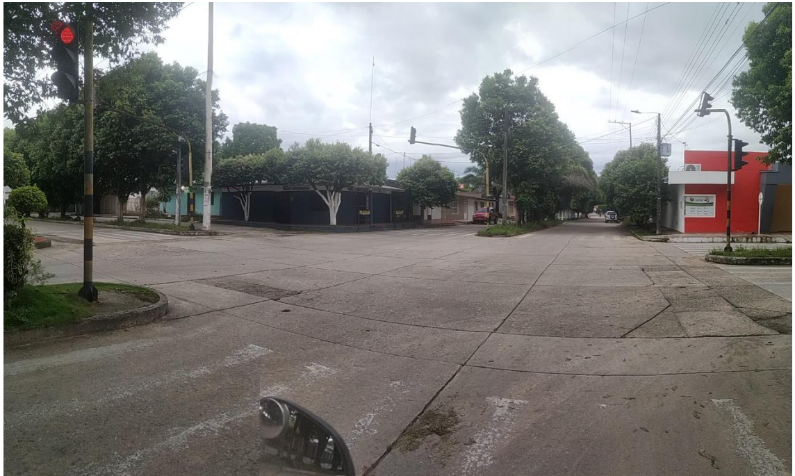
Figura 24. Panorámico tercera intersección, Espacio y fotografía donde se realizó el mantenimiento.
