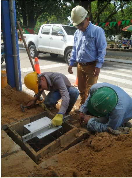
Figura 9. Instalación Canastilla, Nivelación para la instalación y posterior fundición.
