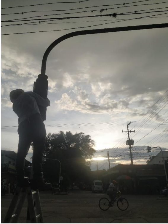
Figura 58. Cambio de lámpara, Apertura del semáforo para cambio de modulo led.
