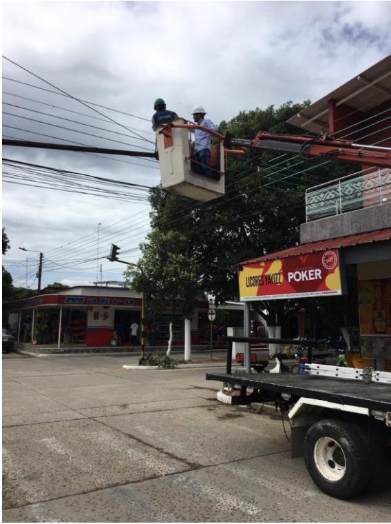
Figura 48. Cambio de lámpara, cambio de lampara color ámbar que presentaba fallas.
