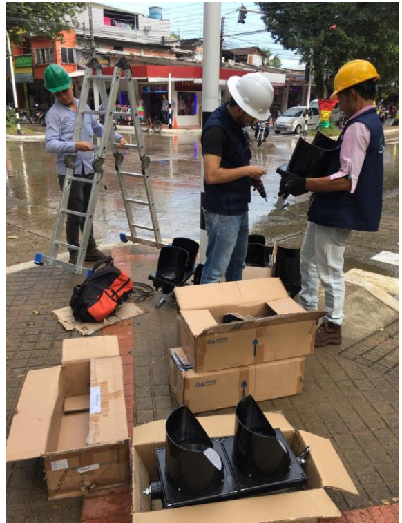
Figura 21. Revisión de los semáforos Peatonales, Revisión del estado de los semáforos peatonales para la instalación.
