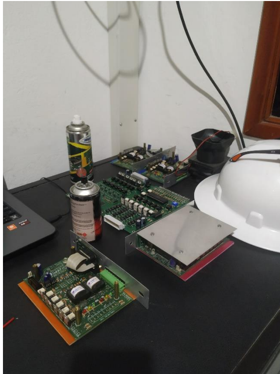
Figura 35. Espacio de trabajo para mantenimiento, Espacio en el que se realizaba los mantenimientos preventivos/correctivos y sus respectivos líquidos que se aplicaban para ello.
