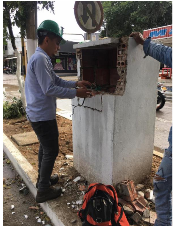
Figura 47. Adecuación Caja de control, Desconexión y demolición de la estructura para adecuación de la nueva caja de control.
