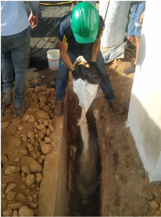
Figura 54. "Enriquecimiento" del suelo, Aplicación de químicos y compuestos como cal, abono entre otros.
