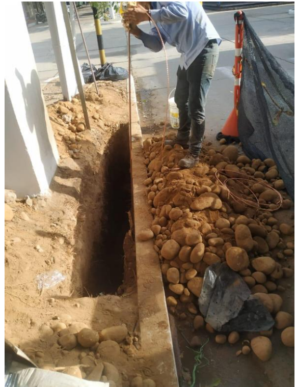
Figura 49. Adecuación puesta a tierra eléctrico, Excavación para la instalación de puesta a tierra eléctrico.
