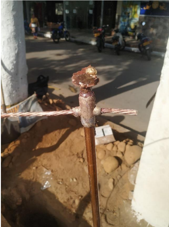
Figura 52. Fundición varilla – cable, Ilustración del estado final después de la fundición.
