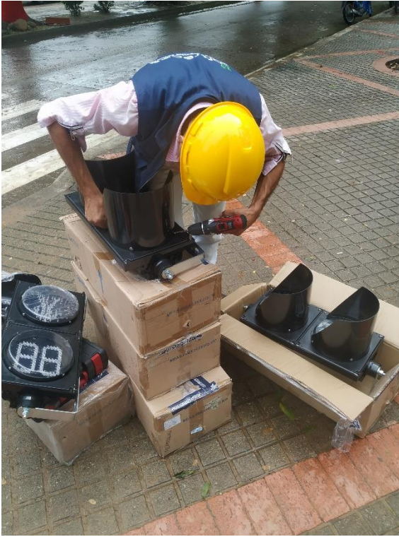
Figura 18. Ensamble de cruce peatonal, unión de las piezas que conforman el semáforo peatonal
