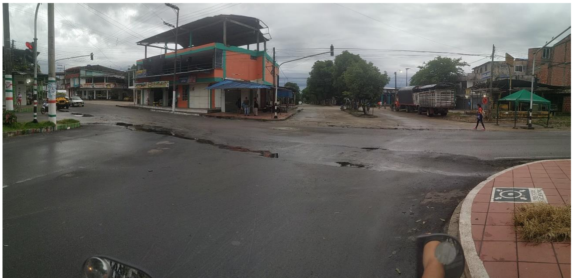
Figura 23. Panorámico segunda intersección, Espacio y fotografía donde se realizó el mantenimiento.
