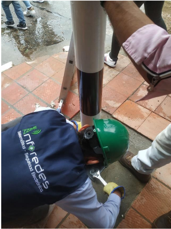
Figura 42. Instalación del mástil, Instalación de mástil sobre la fundición de la canastilla.
