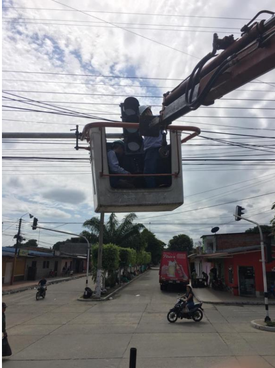
Figura 31. Adecuación nuevo semáforo, Instalación y conexión del nuevo semáforo vehicular dañado por una volqueta.
