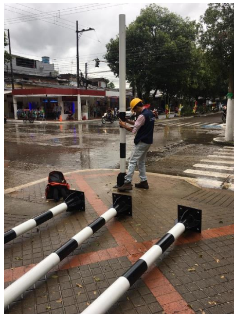
Figura 11. Mástil, Evidencia sobre la estructura y apariencia del mástil.
