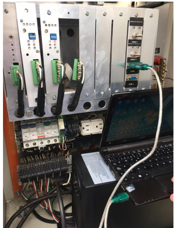
Figura 37. Montaje y Programación, Compilación del nuevo cambio en los tiempos de cambio en las intersecciones.
