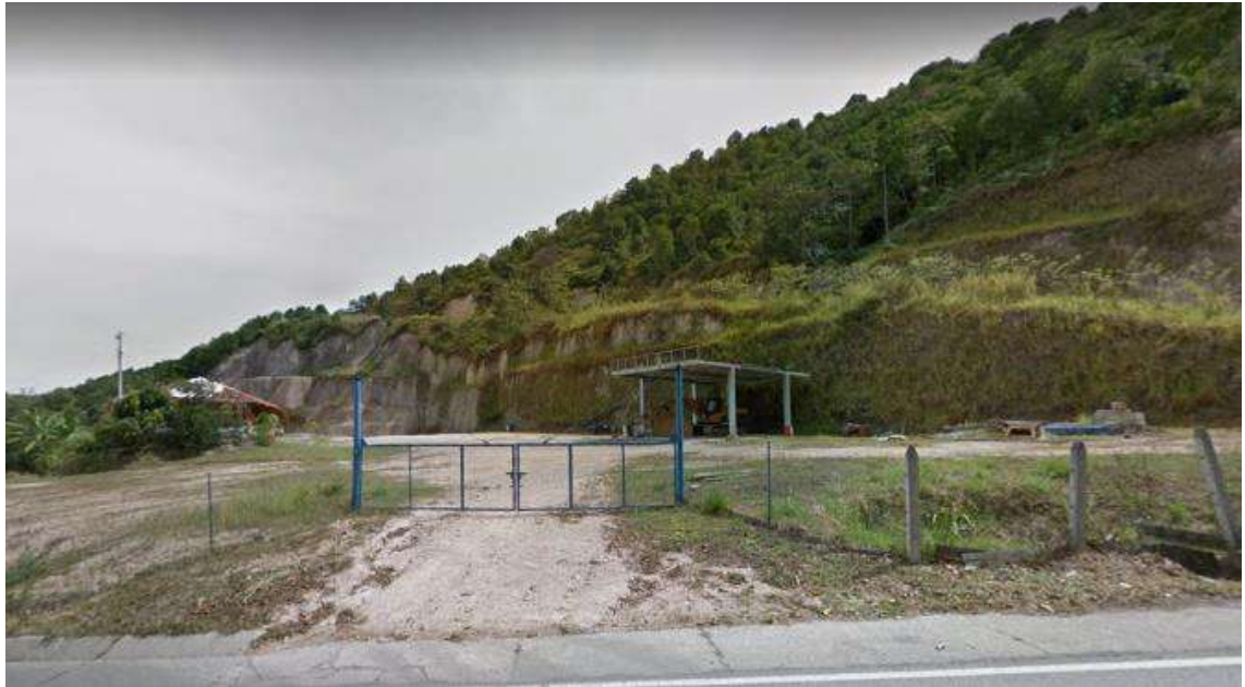
Fotografía N°5: Toma sobre la vía Piedecuesta-San Gil.
