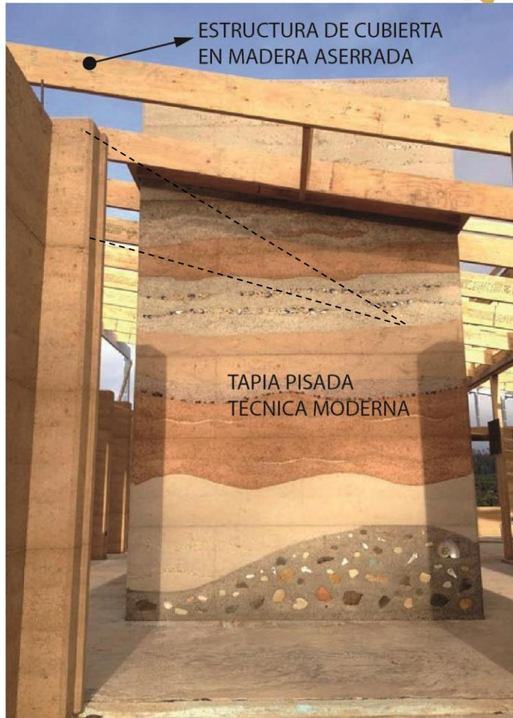
Ilustración 24: Sistema Constructivo
