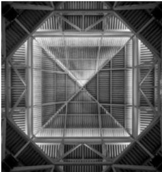
La cubierta ventilada en fibro cemento la cual es termoacústica y sin cielo raso. Los extensos aleros reinterpretan los techos tropicales inclinados comunes en la región. La estructura está hecha con acero, que permite hasta 22m de luz, es independiente del cilindro del ladrillo para una buena respuesta a los sismos. Esto funciona para reforzar la liviandad y el concepto de libertad.
