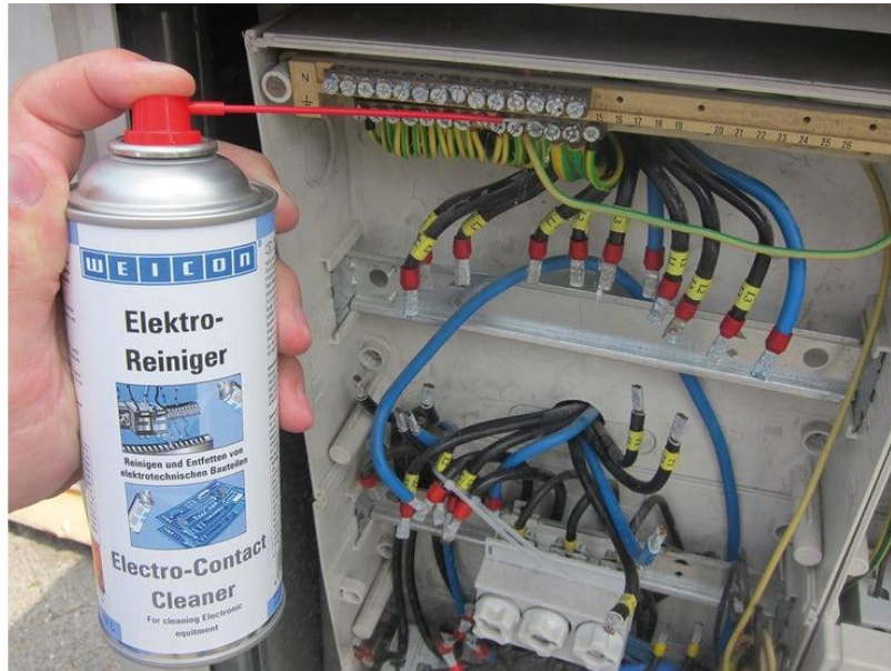
Figura 43. Limpieza de tablero eléctrico.
