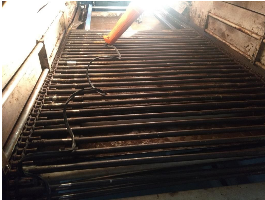
Figura 33. Instalación del sistema transportador de productos.
