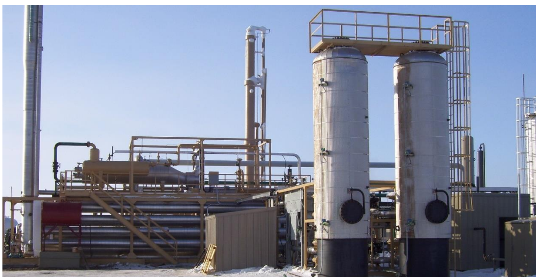
Figura 8. Deshidratadoras de Tamices Moleculares – QB Johnson. (JOHNSON)
