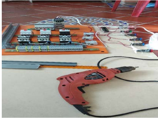
Figura 25. Ensamble y construcción de la lámina base
