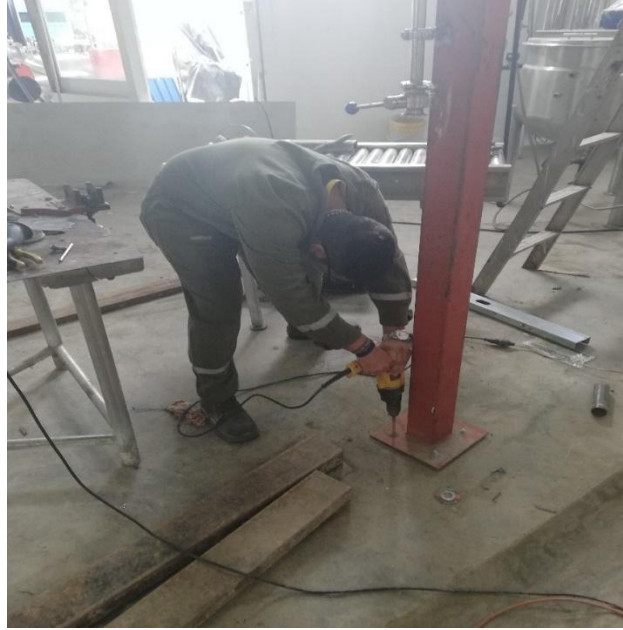
Figura 95. Aseguramiento de pie de amigo para puente grúa. (Fuente: Autor).
