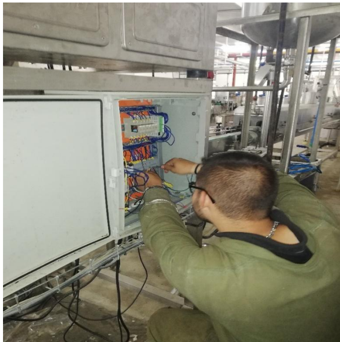
Figura 39. Conexión de cables al tablero de control. (Fuente: Autor).
