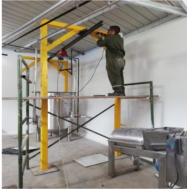
Figura 97. Instalación de topes para puente grúa. (Fuente: Autor)
