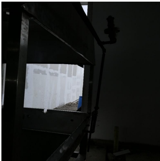
Figura 28. Instalación línea de condensado. (Fuente: Autor).
