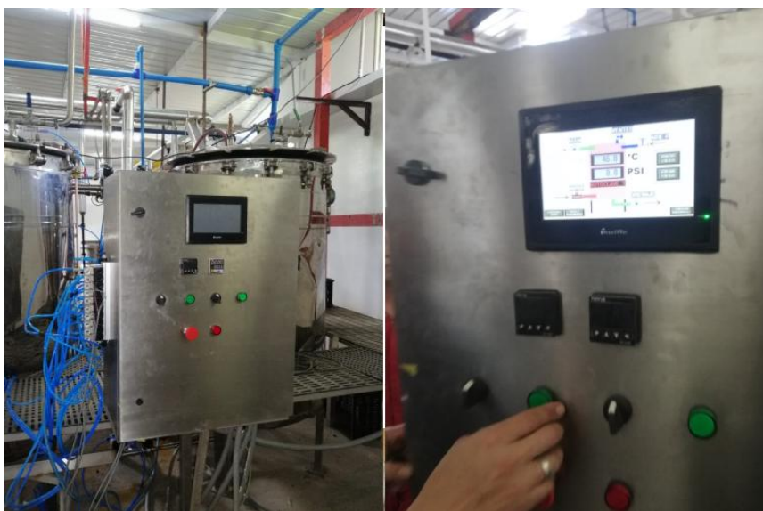
Figura 66. A la izquierda montaje del tablero de control parcialmente terminado, a la derecha prueba del sistema automatizado. (Fuente: Autor).
