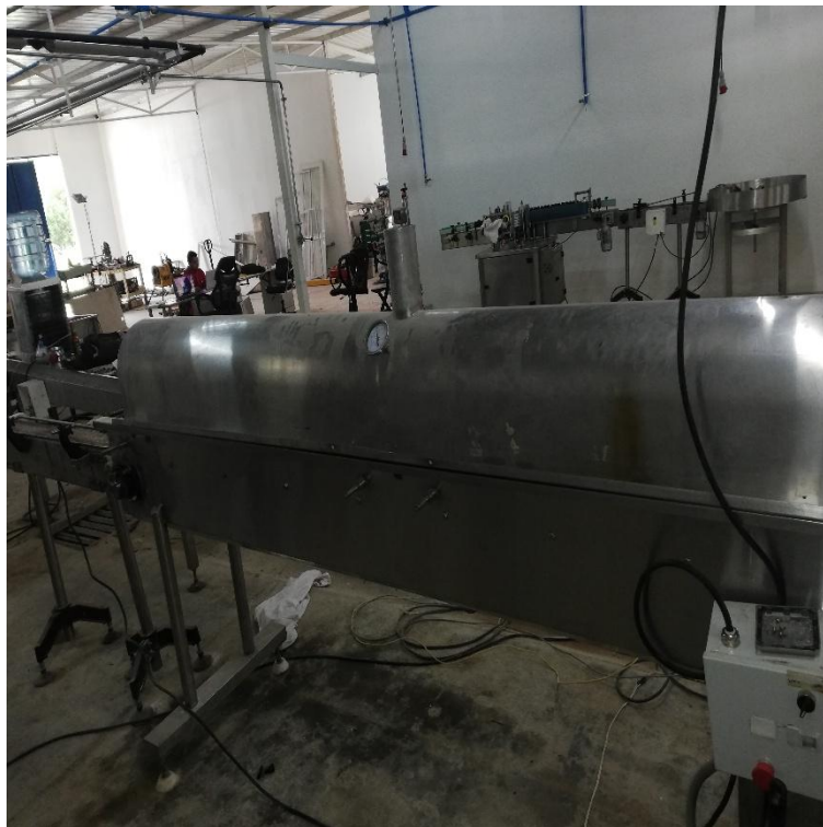
Figura 45. Túnel de Exhausting para vidrio. (Fuente: Autor).
