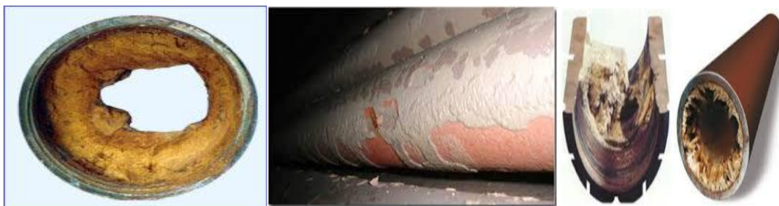
Figura 1. Incrustaciones en tuberías de calderas
