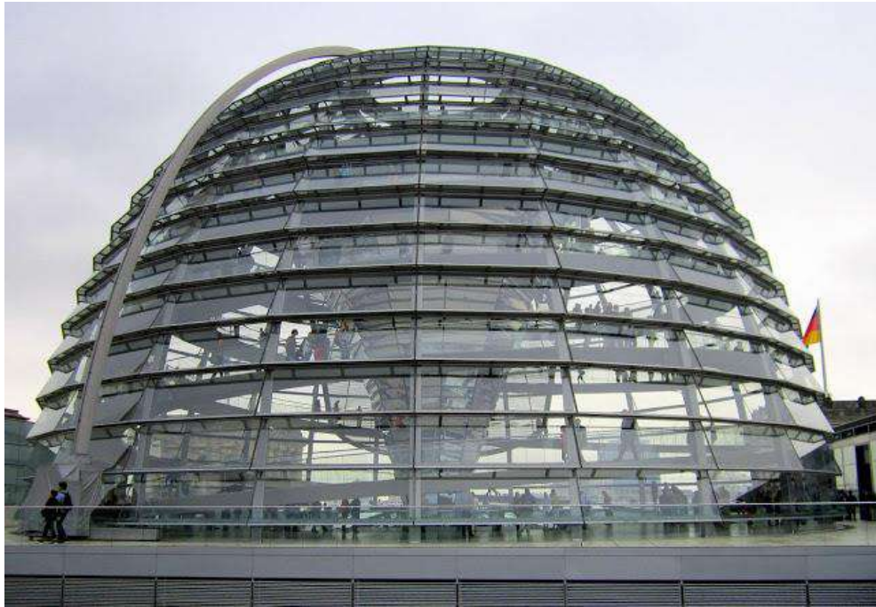
Fotografía 2: Cubierta del edificio Reichstag. Fuente: Foster and partners
