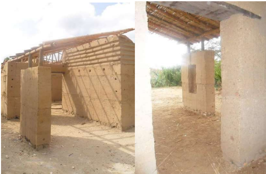
Imagen 11: Muros en tapia pisada
