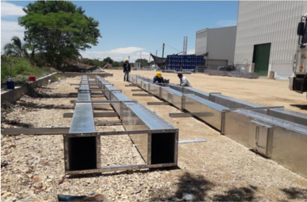
**Figura 3-1.:** Ensamble de piernas de elevador de cangilones: Fuente: Montaje planta de fedearroz El espinal-Tolima .
