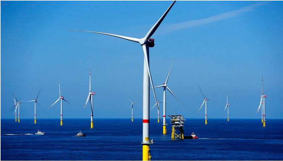
Figura 2-1: Granja de aerogeneradores marinos. Fuente:[10]
