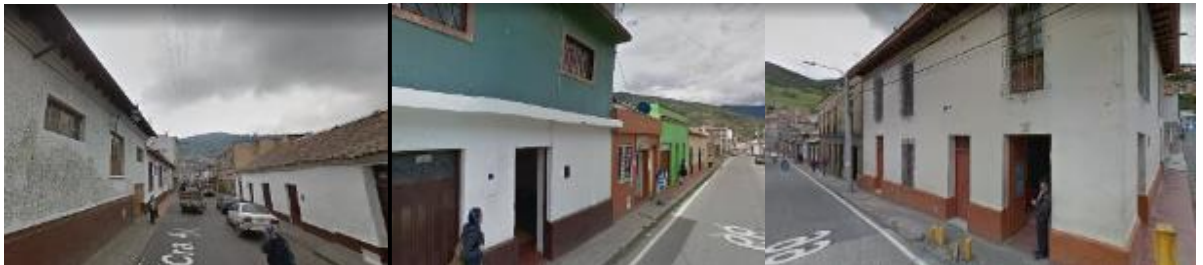
Ilustración 51. Estado de las viviendas del lote.
