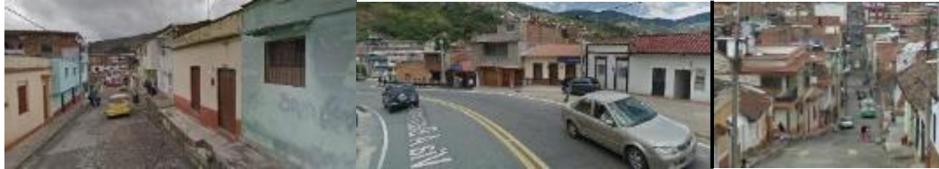
Ilustración 52. Estado de la vivienda
