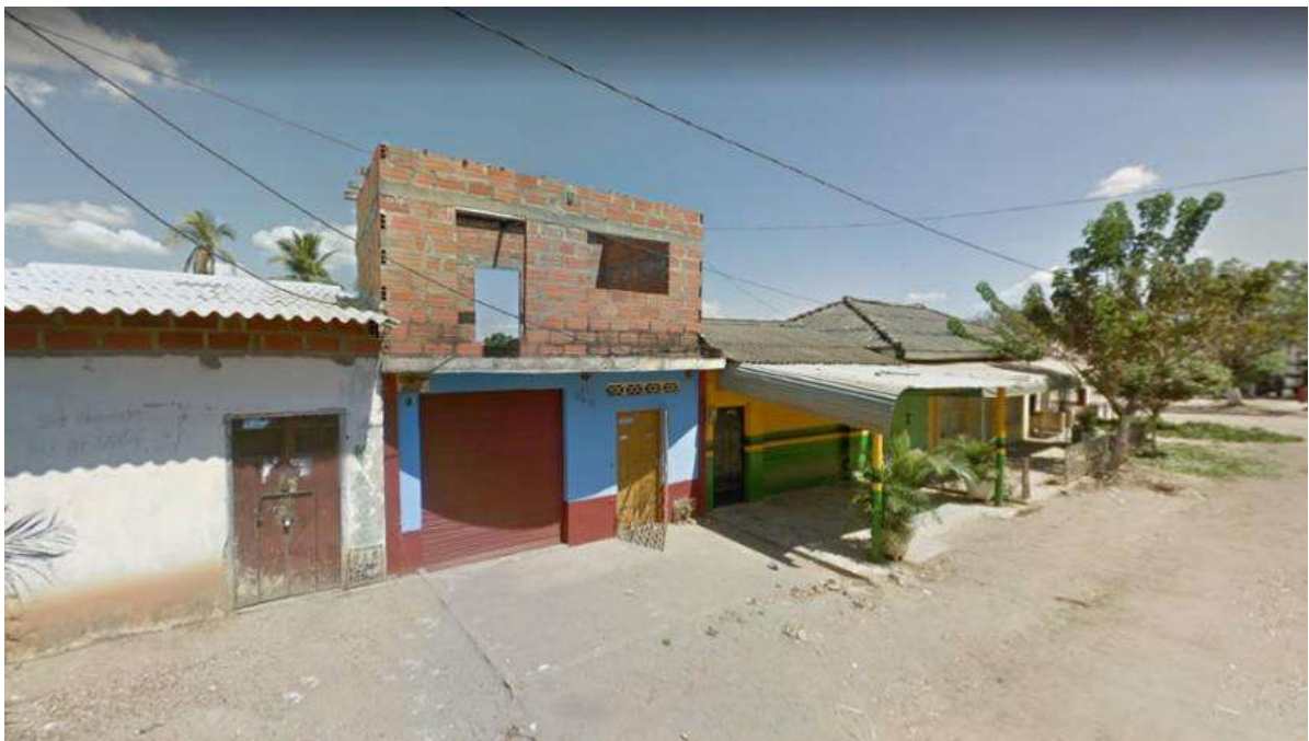
Ilustración 46, Construcciones del área a intervenir, Fuente Google Street.
