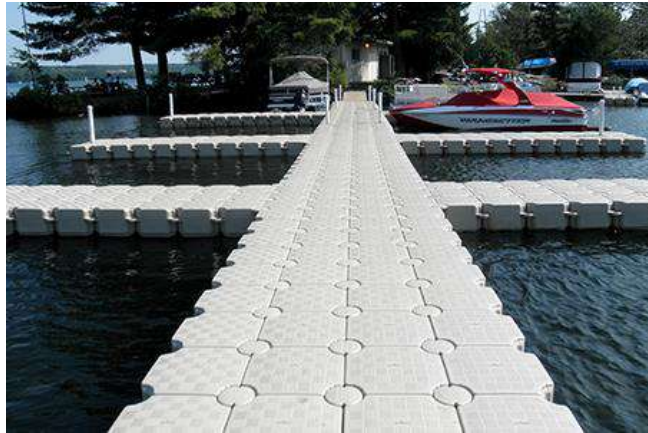
Ilustración 28, Ejemplo fotográfico del muelle por sistema flotante modular
