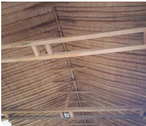
*Ilustración 12 Cubiertas con Caña brava*
