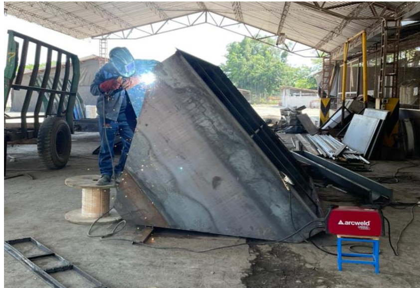
Imagen 12. Unión de las láminas.
