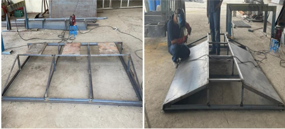
Imagen 15. Estructura para el techo de la tolva.
