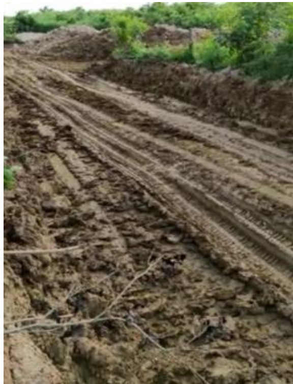
Imagen 3. Deterioro de la vía en épocas de invierno.
