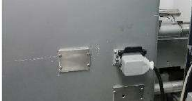
Figura. (7.7) 15: Tomacorriente para energizar estación de alimentación de producto.
