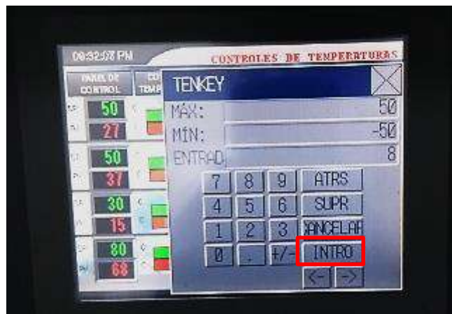
Figura. (7.13) 4: Casillas para calibración de los sensores de temperatura.
