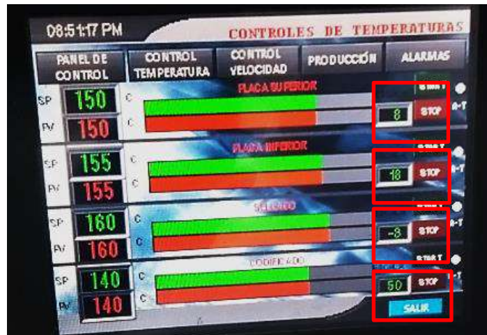
Figura. (7.13) 3: Casillas para calibración de los sensores de temperatura.
