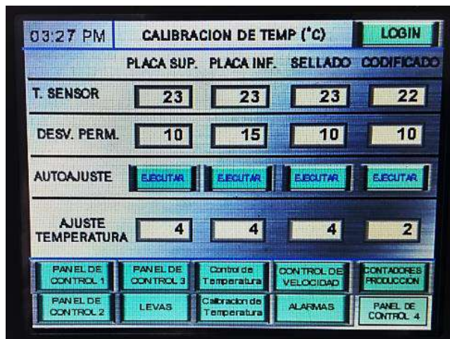
Figura. (7.12) 2: Interfaz calibración de temperaturas blistera #1 EEP-001-PD
