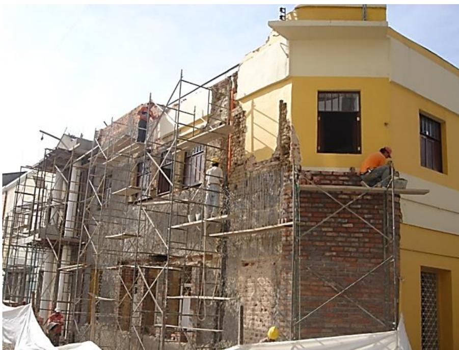
*Ilustración 26 Visualización, relleno de huecos de la formaleta del adobe*
