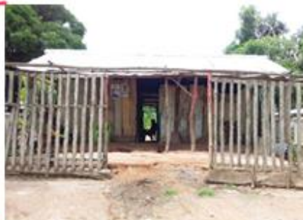
Imagen 9 Vivienda Inadecuada en tablas fuente autor
