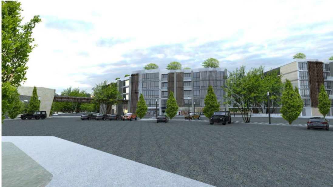
Ilustración 56.. Proyección de vistas, exterior complejo hotelero, zona de parqueaderos
