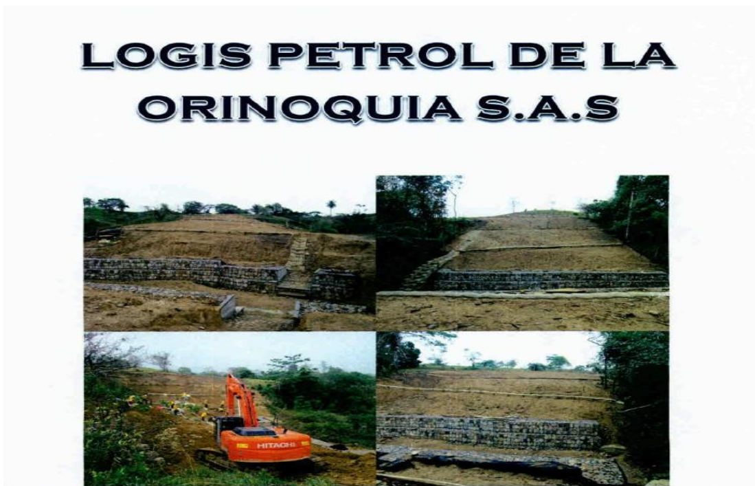
Imagen 1 LOGIS PETROL DE LA ORINOQUIA S.A.S
