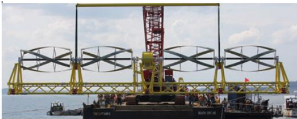
Figura 9. Turbina TidGen instalada en la bahía de Cobscook (Luna, 2016).
