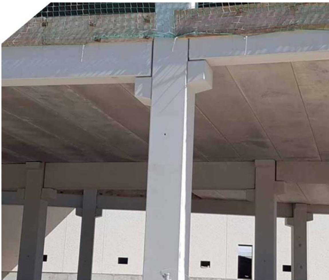
Gráfico 189. Sistema estructural, vista estructural de la losa alveolar. Fuente: catalogo ALVE prefabricados, junio 2020.
