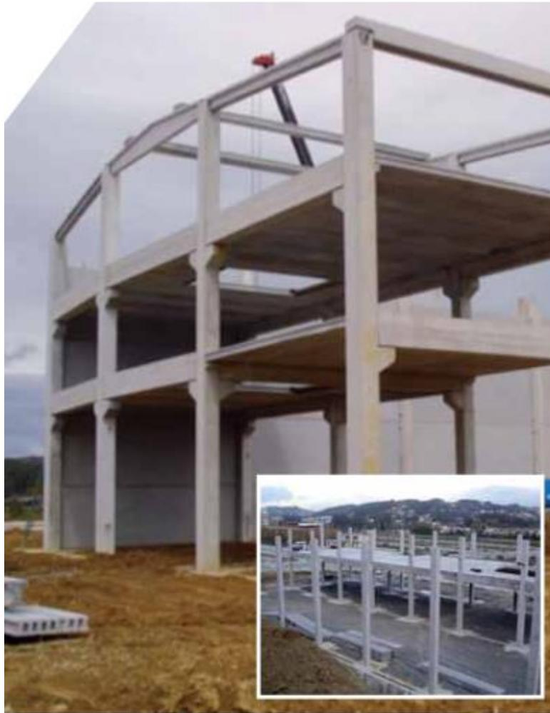
Gráfico 184. Sistema estructural, vista estructural de pilares rectangulares. Fuente: catalogo ALVE prefabricados, junio 2020.
