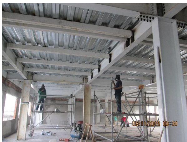
Ilustración 1 Pintado de vigas
