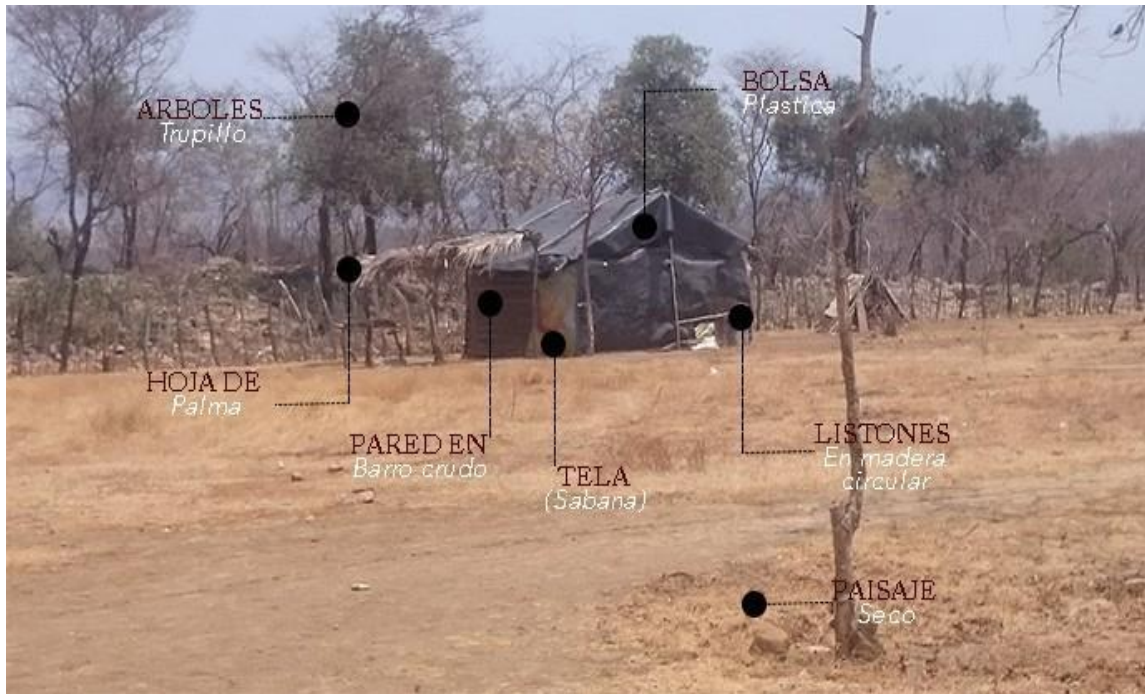
Figura. 1.4 Condiciones actual de una vivienda, resguardo San Francisco. Fuente: Autor 2019.
